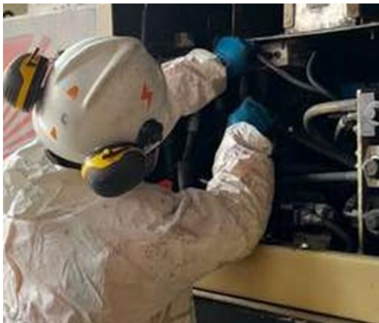
Figura 19. Instalación del cable de zumbador y sensores.
