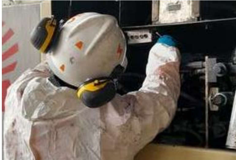
Figura 16. Montaje de la de caja de control.
