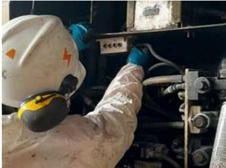
Figura 18. Instalación del cable de alimentación.
