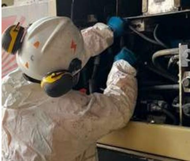
Figura 20. Realizando agujeros con taladro para ubicar el sensor.
