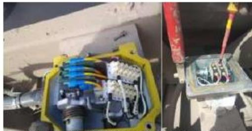
Figura 2. Ajuste y limpieza de borneras en Pull Cord.
