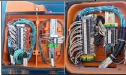
*Imagen 4. Ajuste, limpieza en caja de RTD's.*
