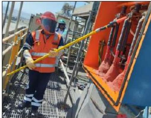
*Imagen 2. Verificación de energía cero en caja de conexiones.*
