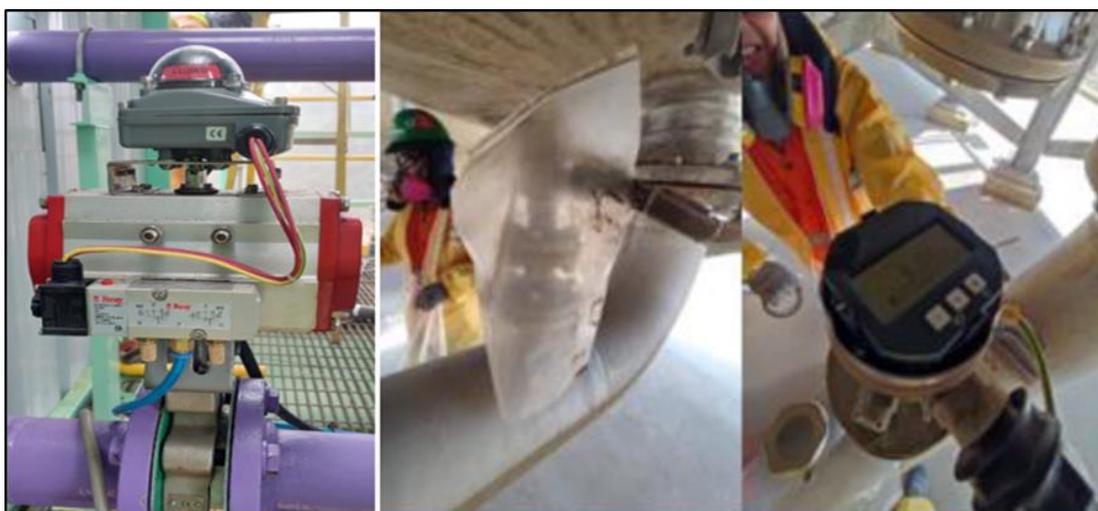
**Figura 19. Mantenimiento de válvula y sensores en clarificador**
