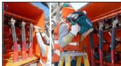
*Imagen 3. Inspección y limpieza de terminales.*
