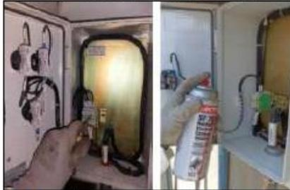
Imagen 7. Inspección, limpieza y verificación de botonera de campo.
