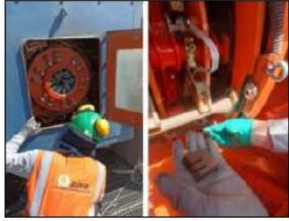
*Imagen 5. Inspección y verificación de carbones.*
