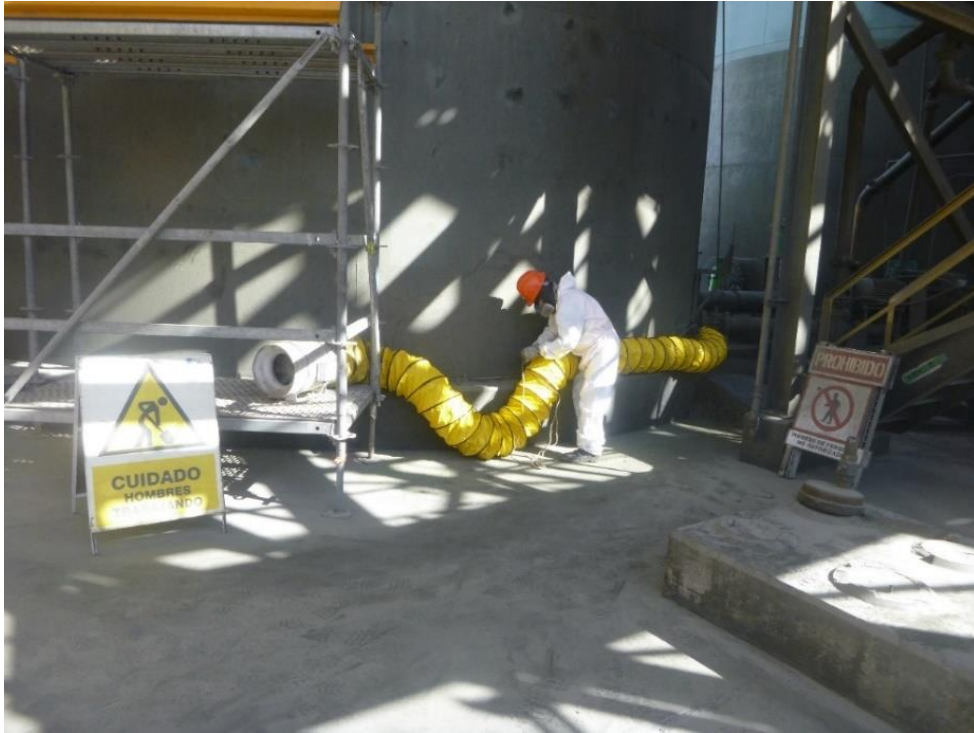
FIGURA 6: Extractor de polvo insertado en el tanque.
