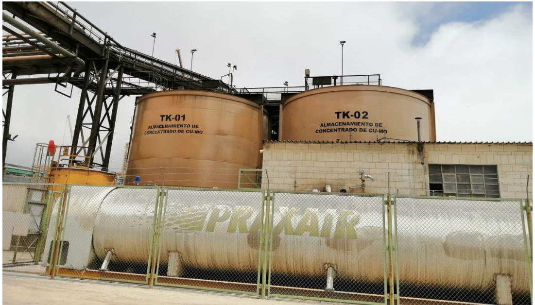
FIGURA 34: Vista de lugar finalizada la actividad.
