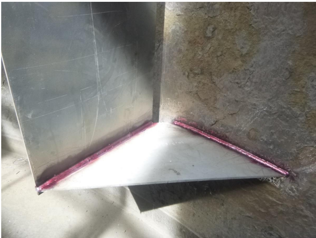
FIGURA 21: Aplicación del penetrante visible removible.
