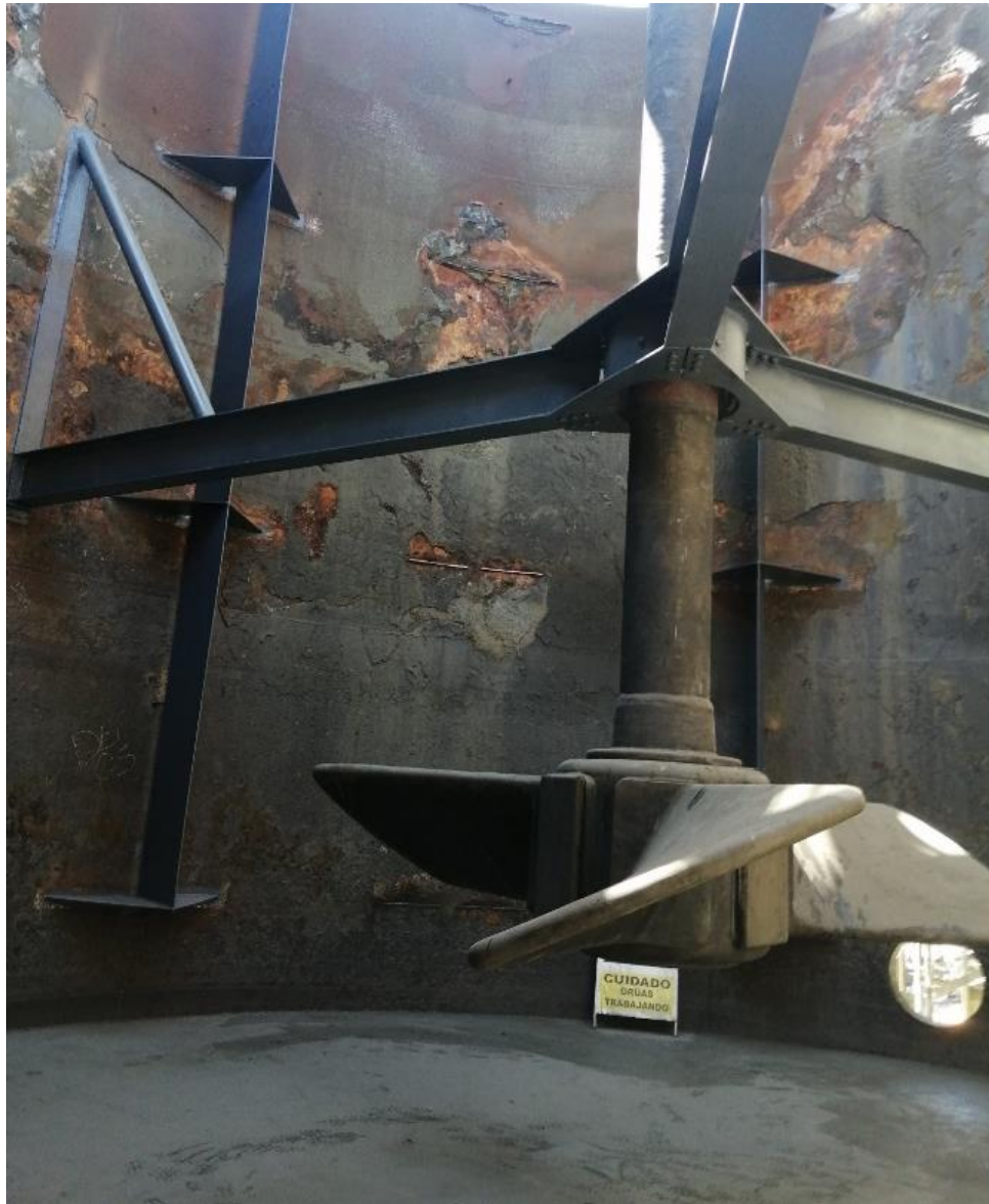
FIGURA 36: Inspección interna de cumplimiento conforme a estándares norma Apl 653.
