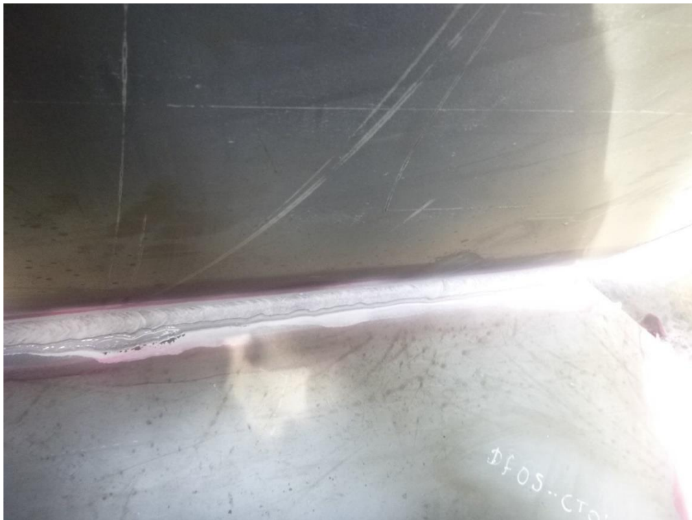
FIGURA 23: Inspección final de unión soldada.
