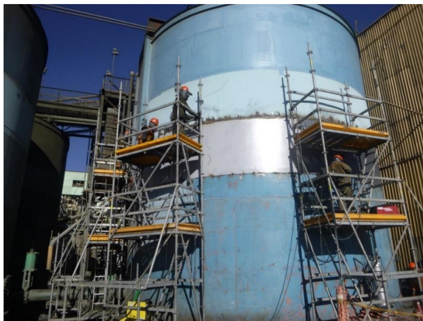
FIGURA 16: Proceso de soldadura SMAW – Reforzamiento de anillo de refuerzo II
