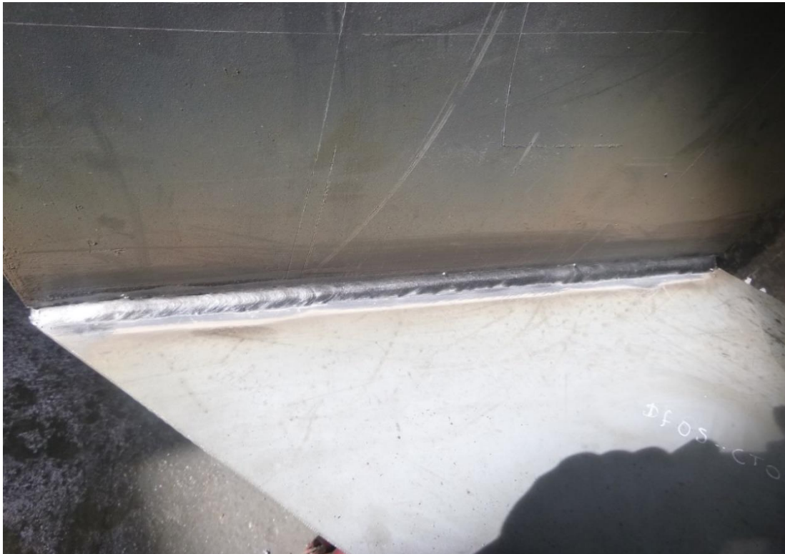
FIGURA 20: Limpieza con solvente limpiador.
