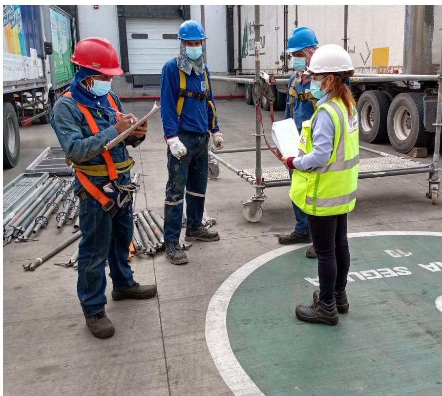
Figura 42. Verificación y revisión de correcto llenado de documentos SSOMA (formatos) - Área de Soldadura
