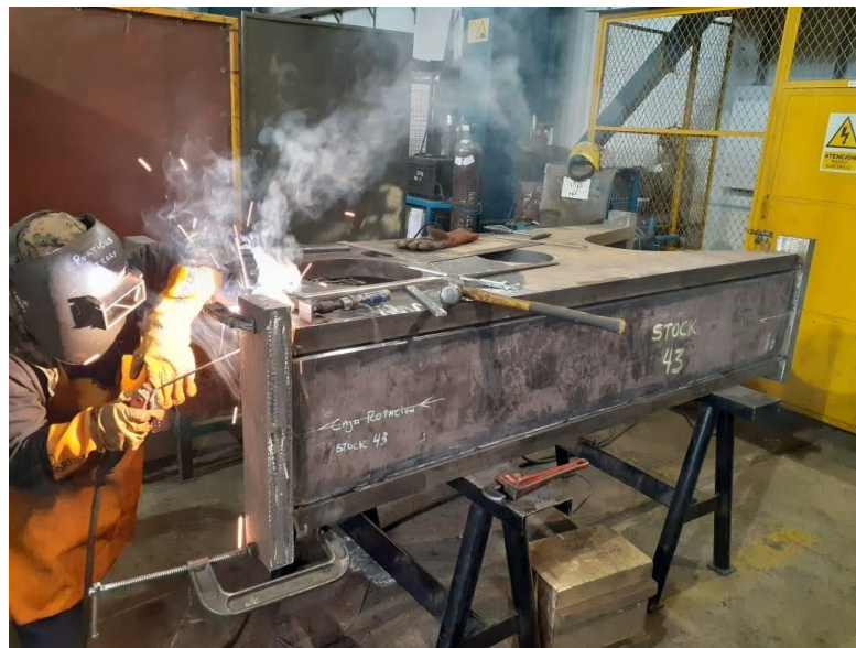
Figura 21. Proceso de soldadura (caja de rotacion)– trabajo de alto riesgo Budge S. A. C.
