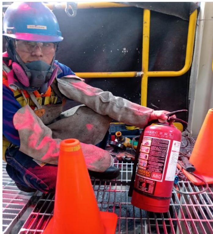
Figura 23. Personal usa correctamente los EPP – Budge S. A. C.
