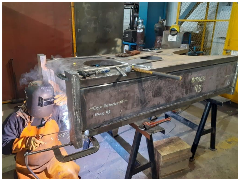
Figura 16. Proceso de soldadura (SMAW) - Budge S. A. C.
