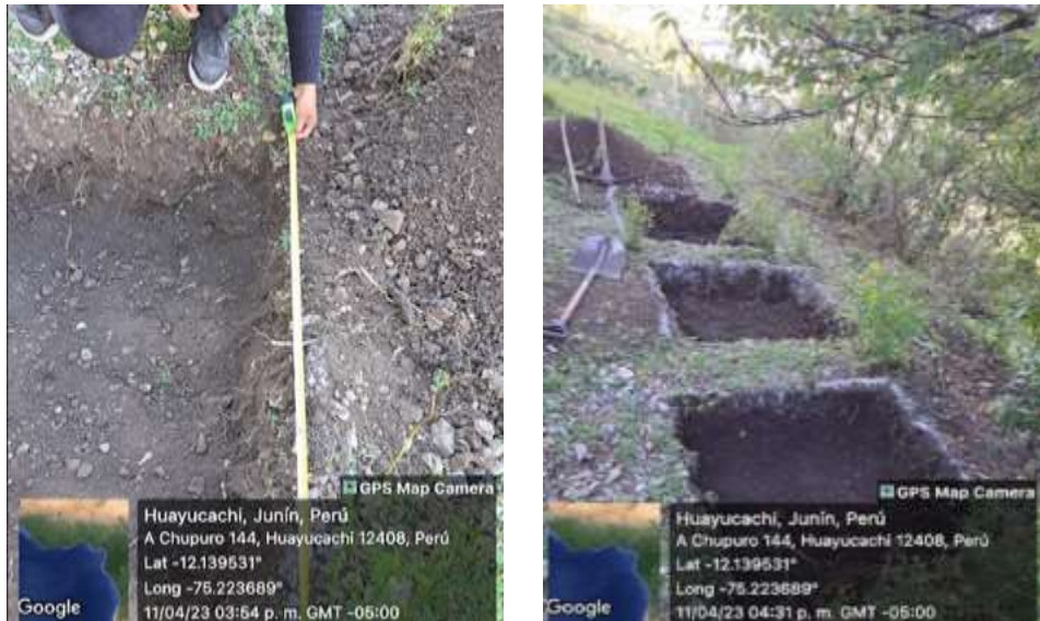
Figura 6. Excavación de las pozas experimentales
