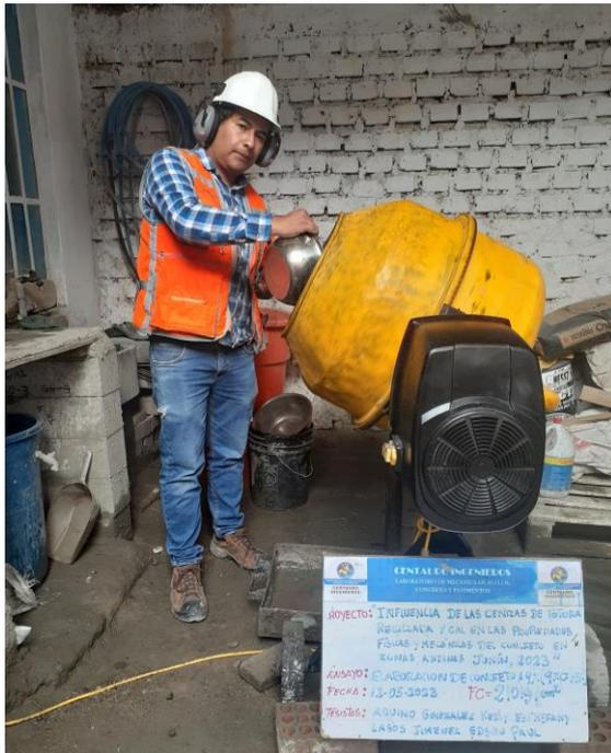
Fotografía 9. Elaboración de la mezcla de concreto.
