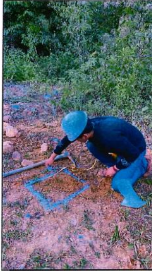
Fotografía N. 01: Extracción de calicata 01
