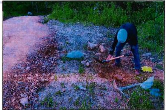
Fotografía N. 04: Extracción de calicata 01
