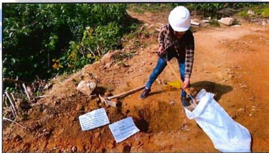
Fotografía N. 29: Extracción de calicata 04
