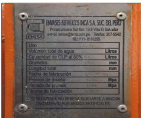
*Figura 17. Placa de temperatura/presión en los cilindros de GLP*
