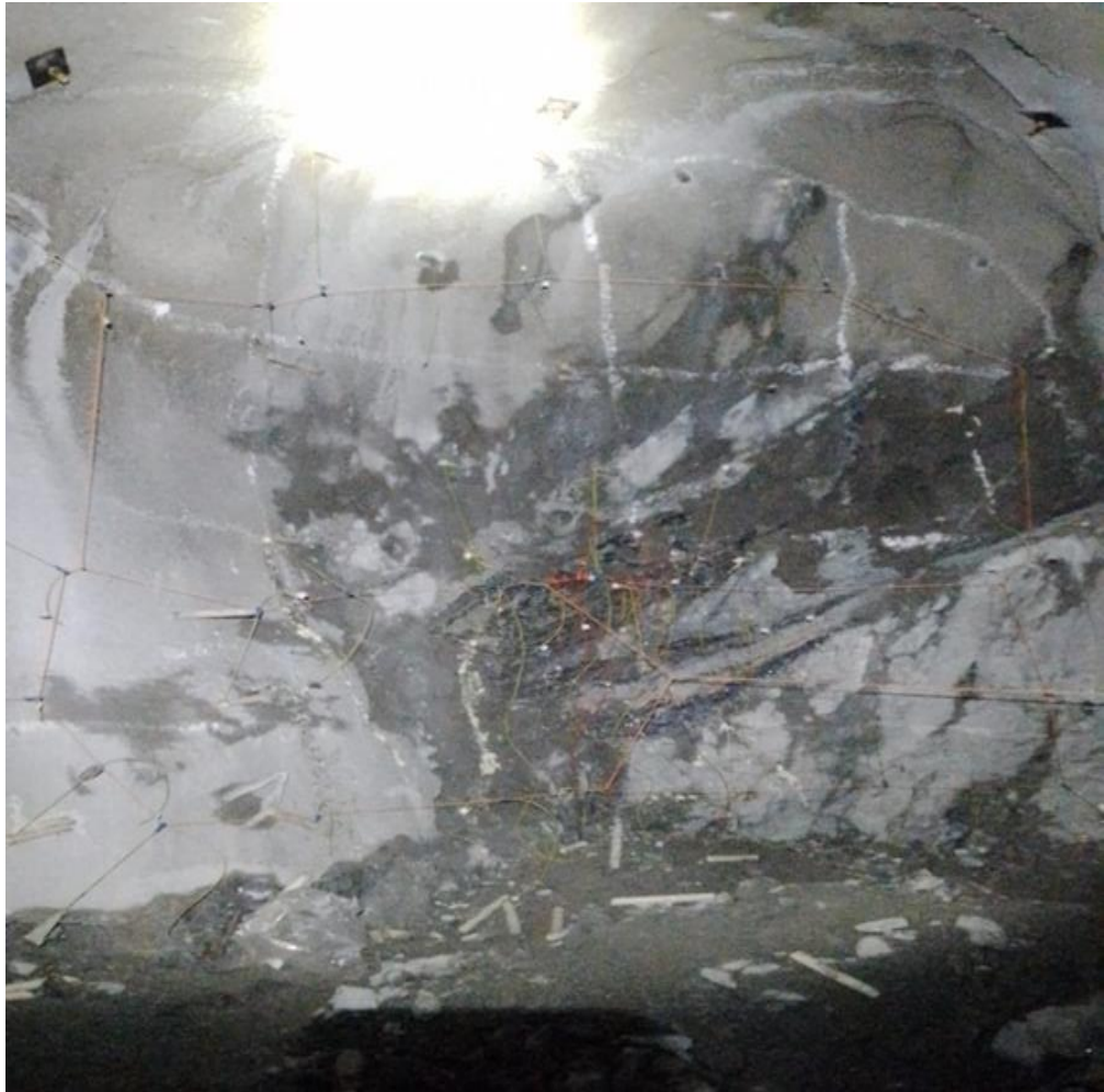
Figura N. 14: Escenario actual – Amarre y chispeo para la voladura de una rampa principal de sección de 4.5 m x 4.5 m con explosivo Subtek™ Charge y Subtek™ Control
