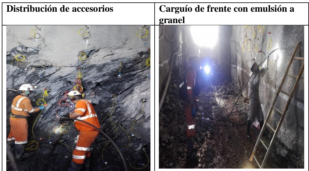
Figura N. 13: Escenario actual – carguío de la malla de perforación y voladura de una rampa principal de sección de 4.5 m x 4.5 m con explosivo Subtek™ Charge y Subtek™ Control
