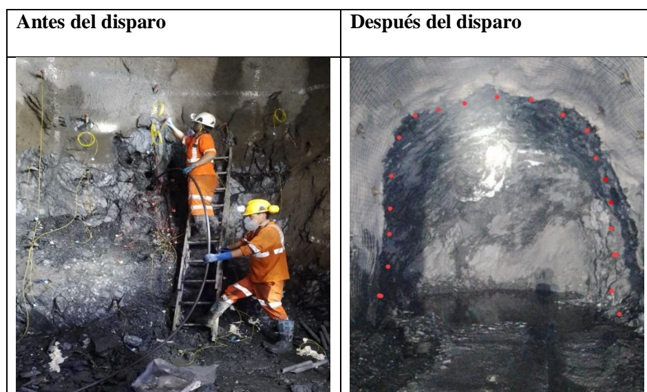
Figura N. 15: Escenario actual – Primer disparo resultado del primer disparo de una rampa principal de sección de 4.5 m x 4.5 m con explosivo Subtek™ Charge y Subtek™ Control
