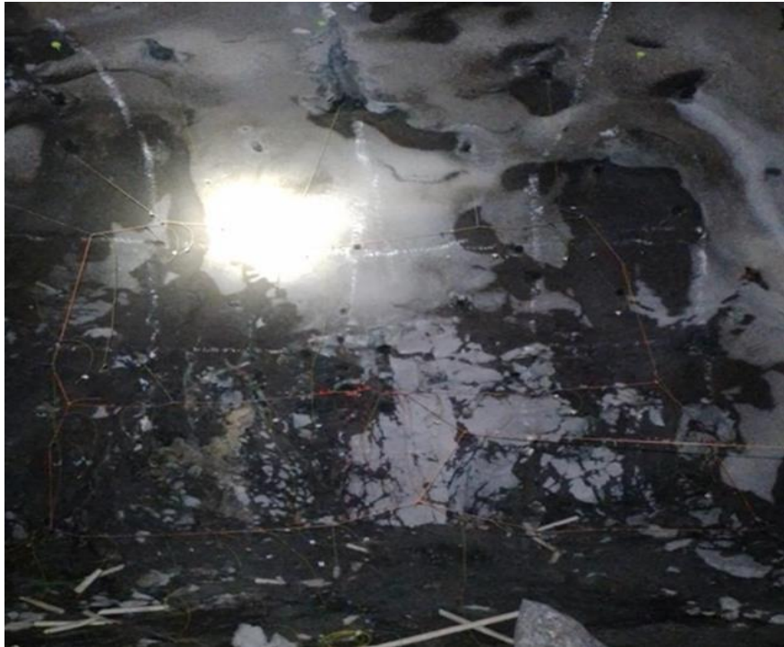
Figura N. 6: Escenario anterior – Amarre y chispeo para la voladura de una rampa principal de sección de 4.5 m x 4.5 m con Emulnor encartuchado
