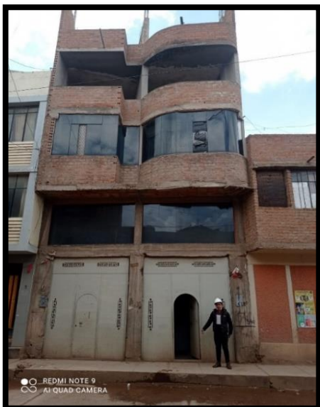
Fachada de la Vivienda
