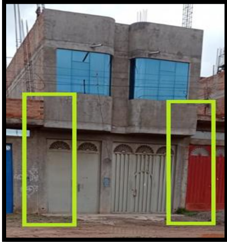
Figura 43: Inexistencia de Juntas Sísmicas con los Vecinos
