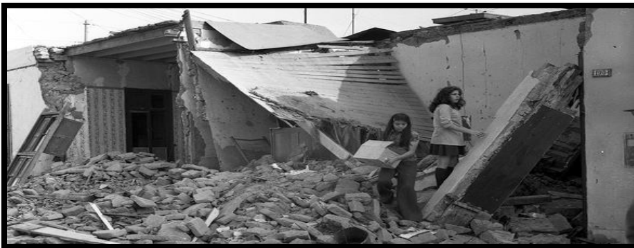
Figura 3: Viviendas de Adobe y Quincha Afectadas por el Sismo.
