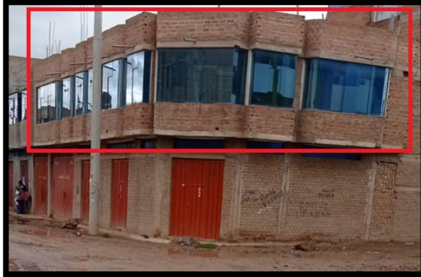
Figura 45: Presencia de Columna Corta
