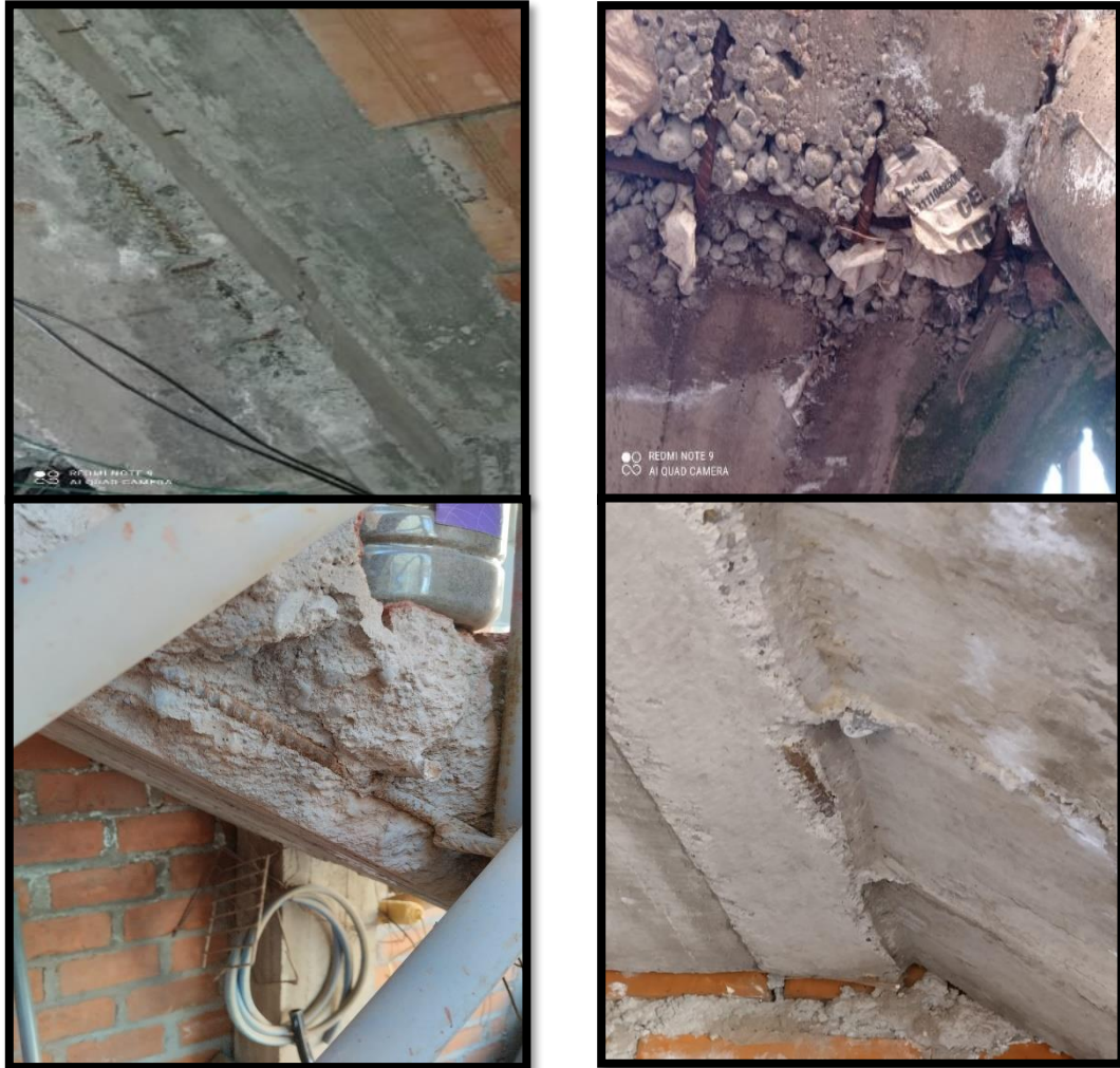
Figura 55: Exposición del Acero de Refuerzo
