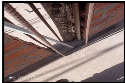
Figura 48: Montantes, Tubos de Agua y Electricidad Atraviesan la Estructura.
