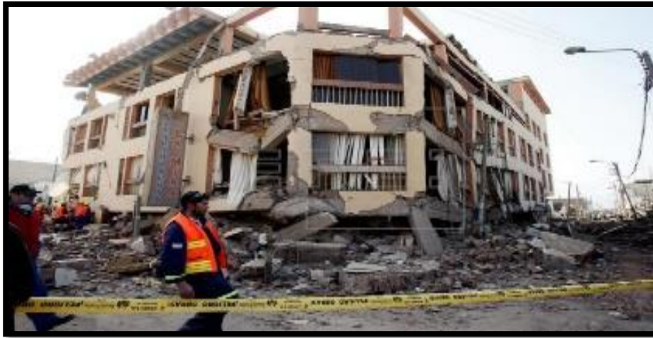
Figura 6: Un Edificio en Ruinas en una de las Calles de Pisco.
