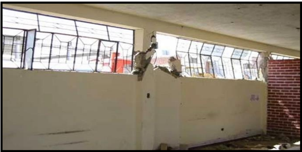
Figura 15: El Efecto de columna corta en edificaciones.
