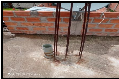
Figura 48: Montantes, Tubos de Agua y Electricidad Atraviesan la Estructura.
