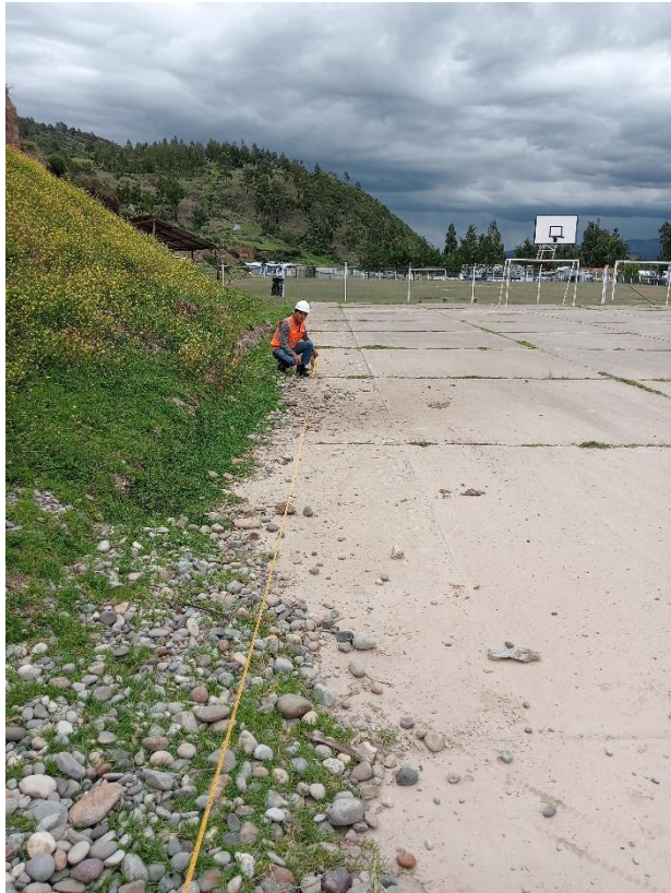
Foto N°5: Lado oeste de la losa deportiva N°1
