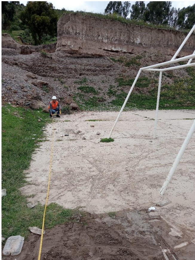
Foto N°4: Lado sur de la losa deportiva N°1
