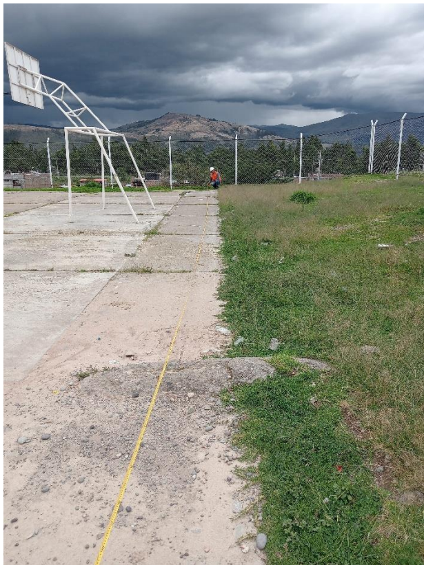
Foto N°6: Lado sur de la losa deportiva N°1
