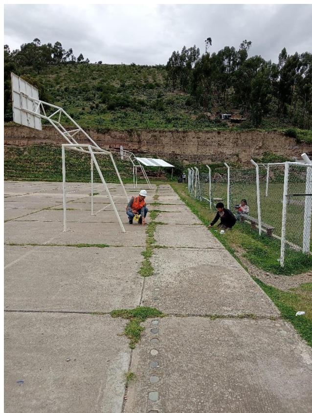
Foto N°8: Lado norte de la losa deportiva N°1
