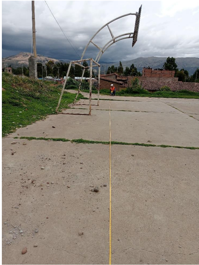
Foto N°13: Lado norte de la losa deportiva N°3
