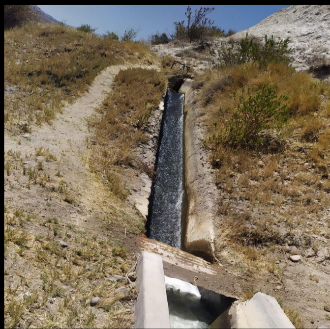
PROGRESIVA 04+218 HASTA 04+230 EROSION DE MUROS DE CANAL
