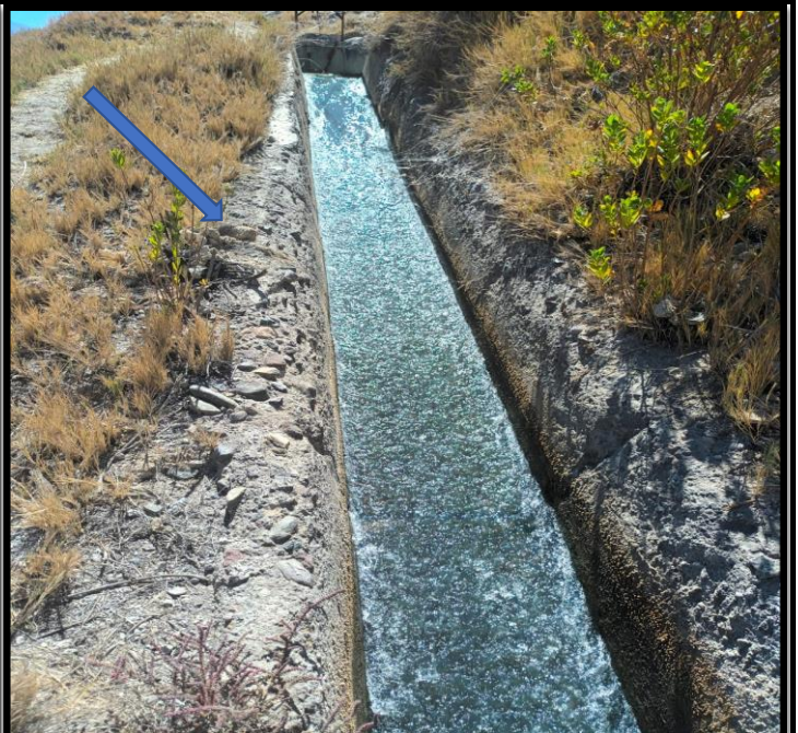
PROGRESIVA 04+218 HASTA 04+230 EROSION DE MUROS DE CANAL
