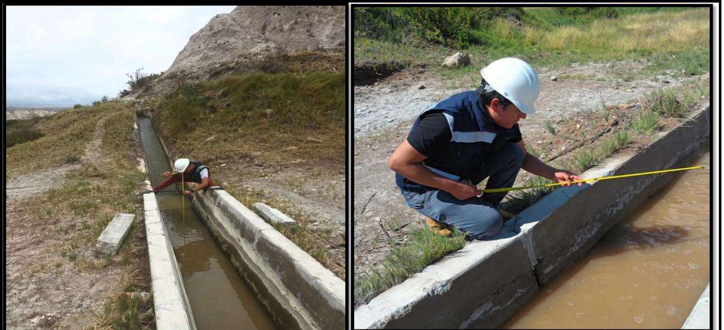
SE TOMA LAS MEDIDAS DE LA SECCION DE CANAL PARA EL AFORO DE CAUDAL POR EL METODO DEL FLOTADOR
