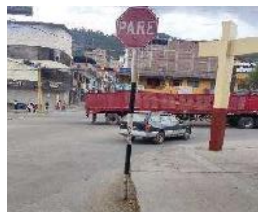
Se observa (R-1) señal de pare dentro de la calzada, en la intersección lázaro Carrillo y Av. José María Arguedas
