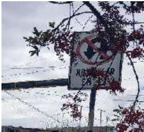
Se observa señal de prohibido voltear en "U" (R-10). Obstruida por vegetación.
