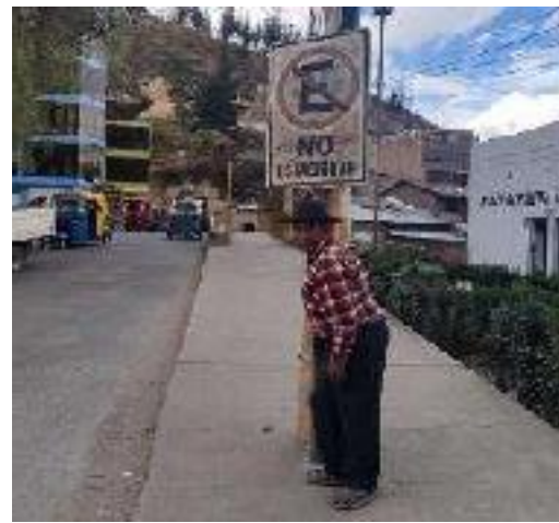
Se observa (R-27) señal de prohibido estacionar deteriorada y sin la altura mínima en áreas urbanas.
