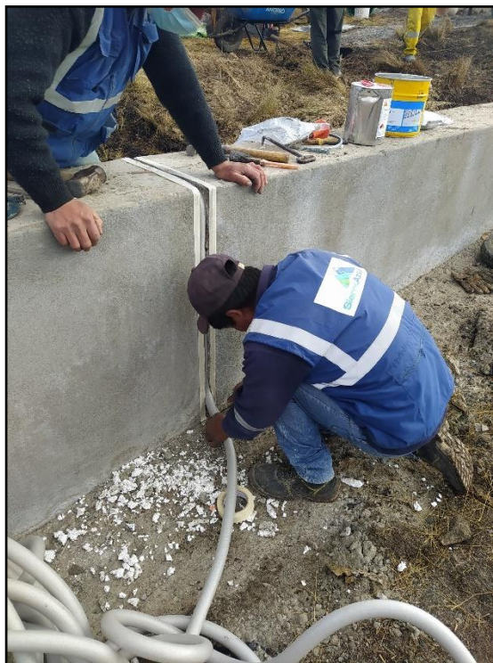
Fotografía de sellado de juntas de dilatación
