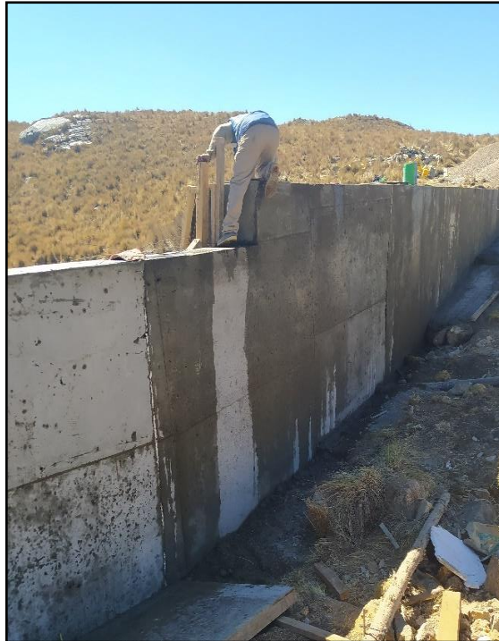
Fotografía cuadrilla de desencofrado
