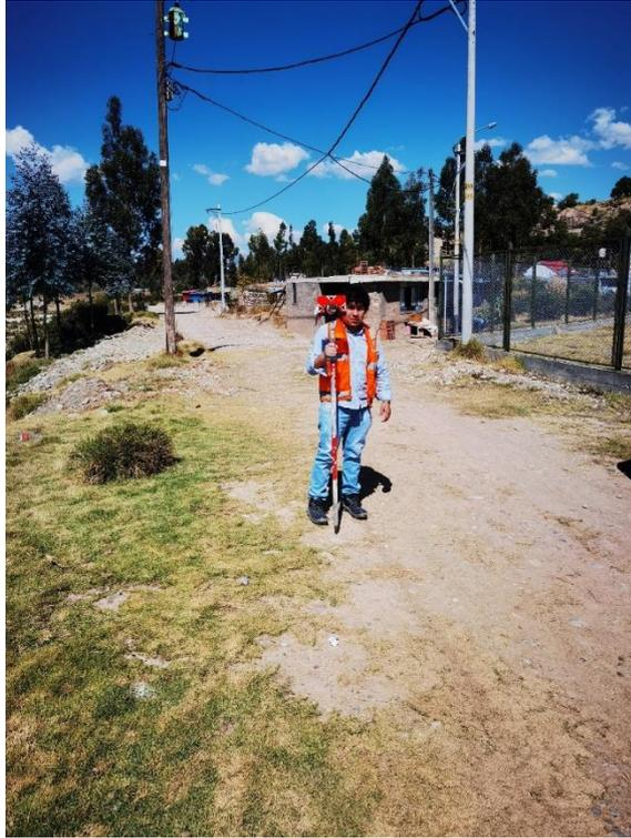
*Figura N° 10.* Personal con prisma para la medición de puntos. Elaboración Propia
