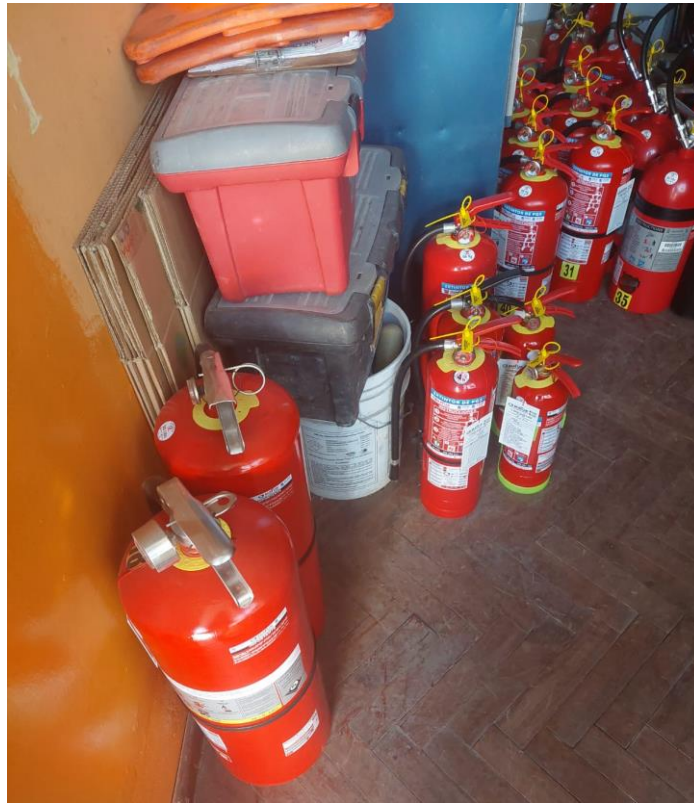
Figura 19. Evidencia de la falta de limpieza en el almacén y ubicación aleatoria de extintores
