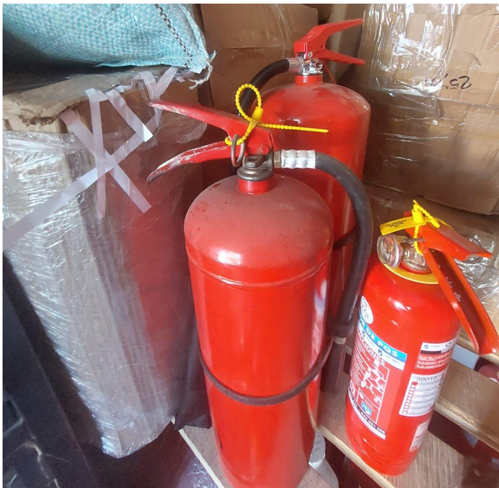
Figura 26. Evidencia de deterioro de productos.
