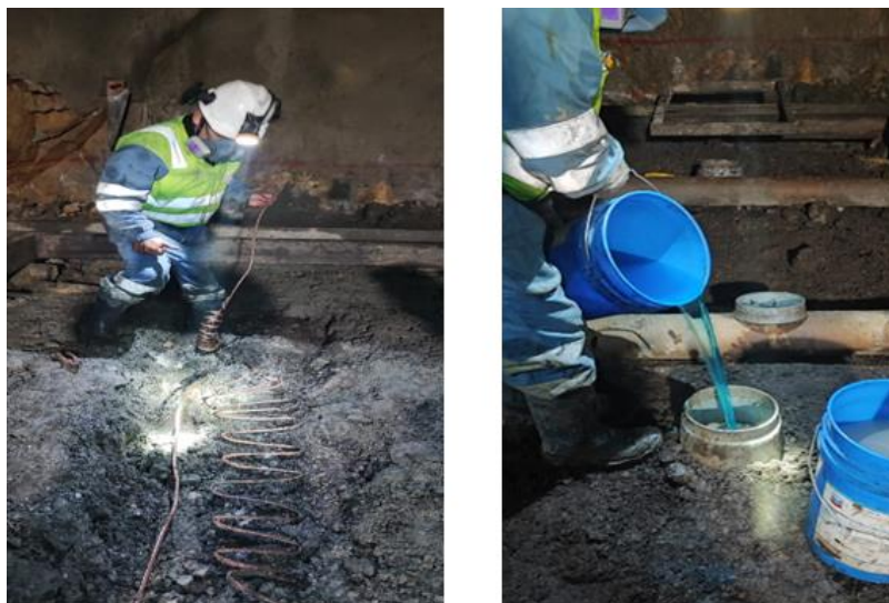
Figura 18. Construcción de poza a tierra 1.
