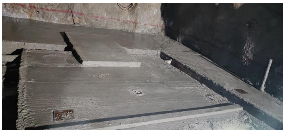
Figura 19. Construcción de poza a tierra 2.
