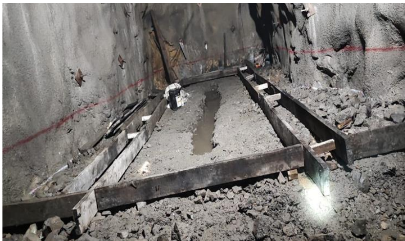
Figura 17. Encofrado del piso y cunetas de la subestación.
