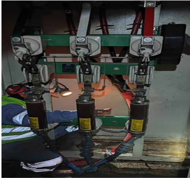
Figura 35. Instalación de conductor de 3 \times 95 \text{ mm}^2 + 1 \times 50 \text{ mm}^2 en celda de MT.
