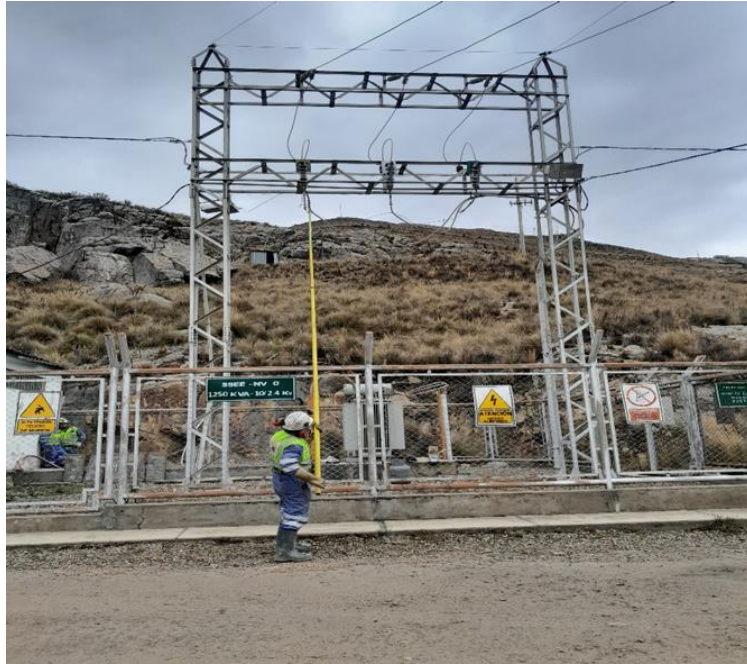
Figura 30. Energización de la subestación en el Nivel 0.
