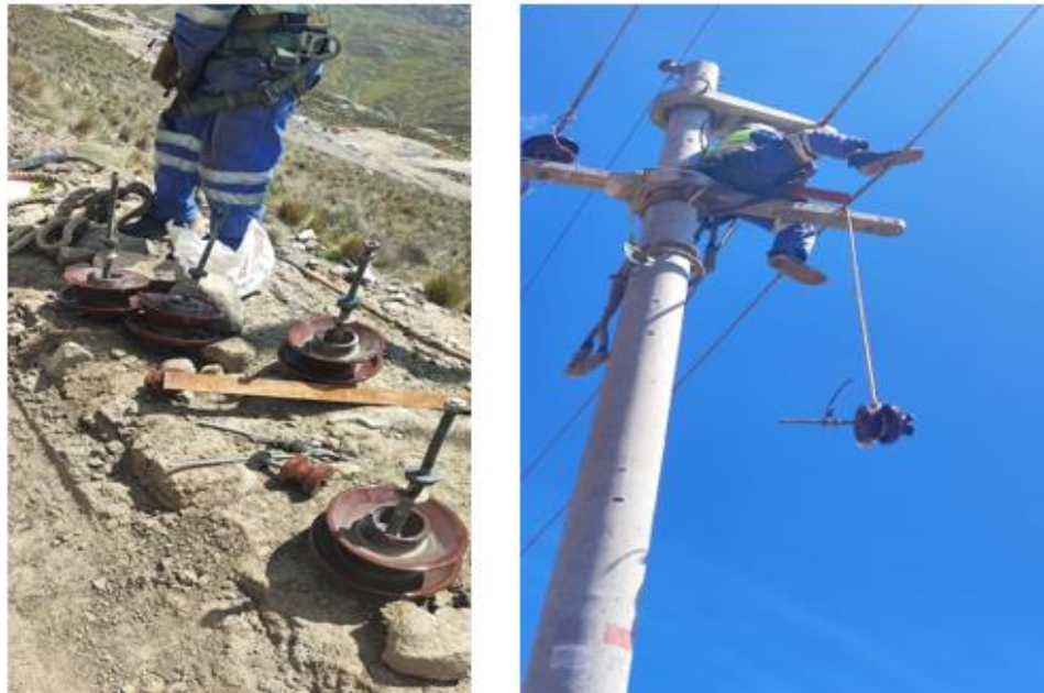
Figura 11. Instalación de bushings .
