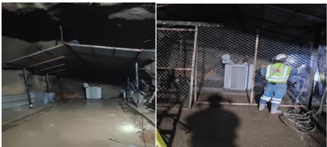
Figura 21. Fabricación del pörtico e instalación del transformador.
