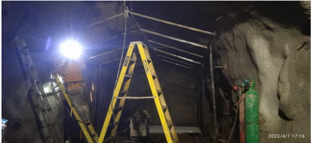
Figura 20. Construcción del techo de la subestación.
