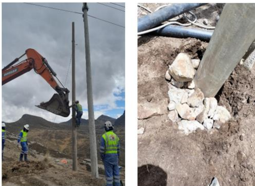
Figura 8. Recuperación de postes de concreto.
