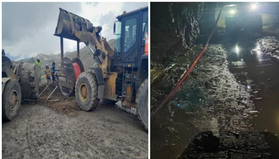
Figura 27. Ingreso del cable de media tensión desde la superficie.
