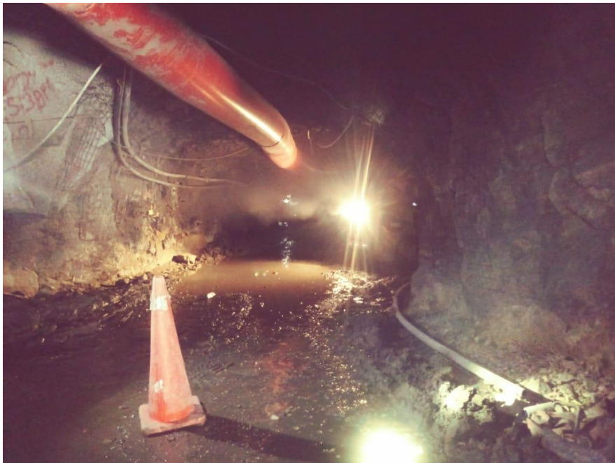
Figura 5. Iluminación en interior del socavón.
