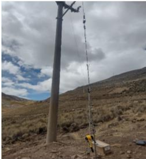
Figura 10. Flechado de los postes de concreto.
