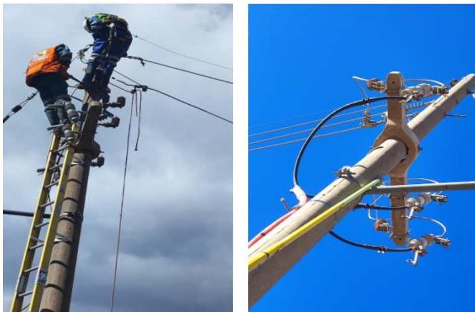
Figura 13. Instalación de cut-out .
