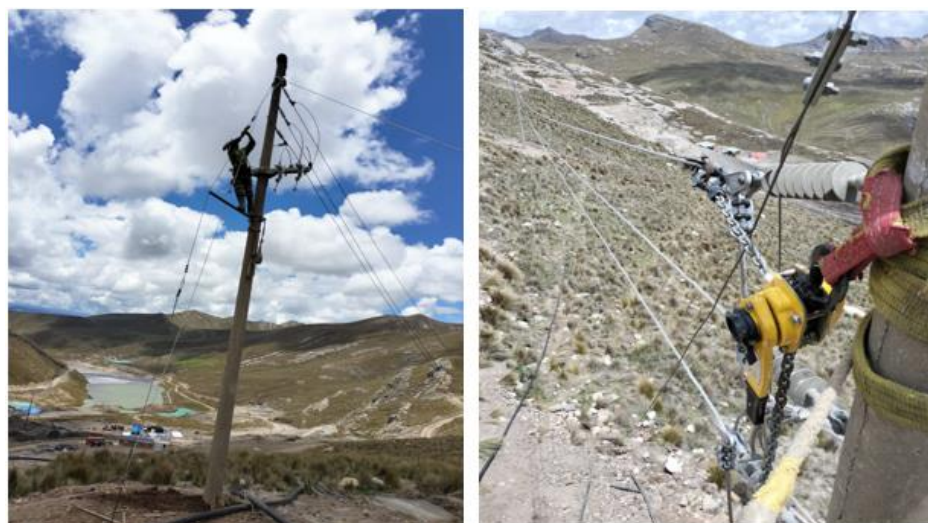
Figura 12. Izaje y tendido del conductor eléctrico.
