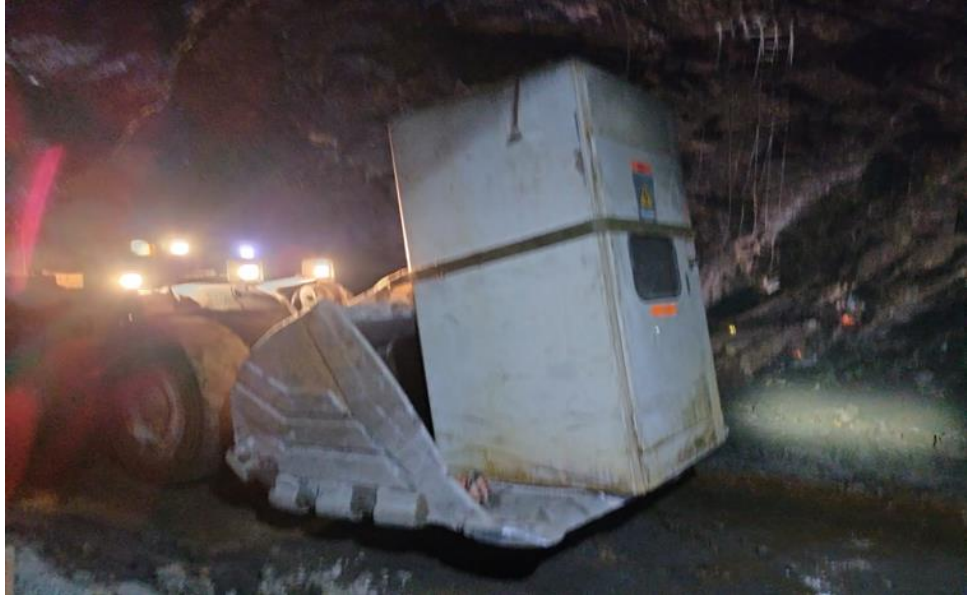
Figura 22. Traslado de la celda de media tensión.
