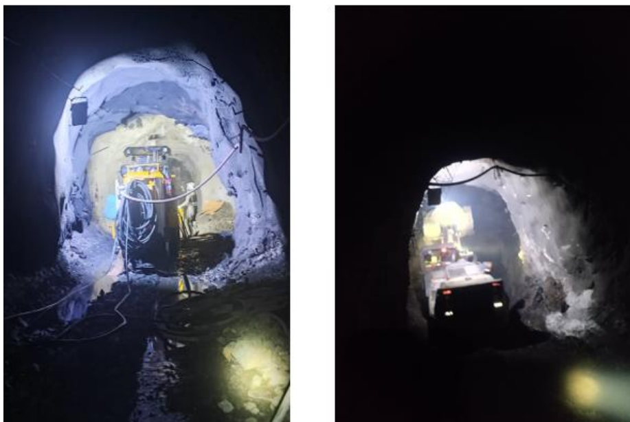
Figura 15. Construcción de la CA-555.
