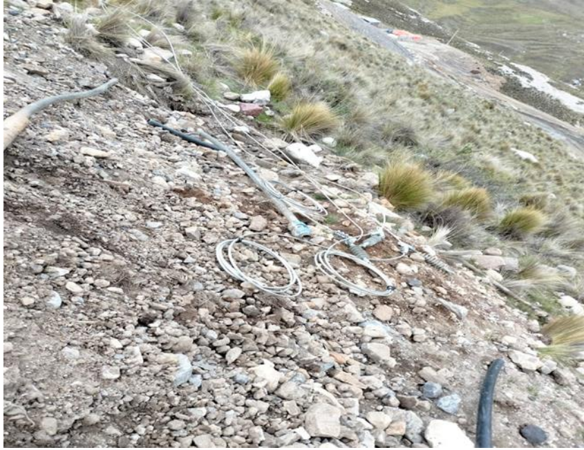
Figura 9. Recuperación del cable de aluminio de 120 mm.
