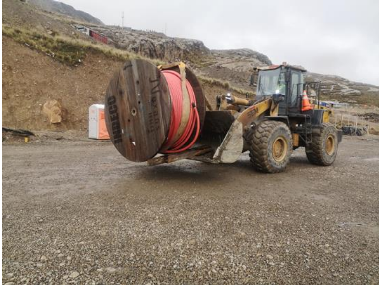
Figura 14. Traslado del conductor de media tensión tetrapolar.
