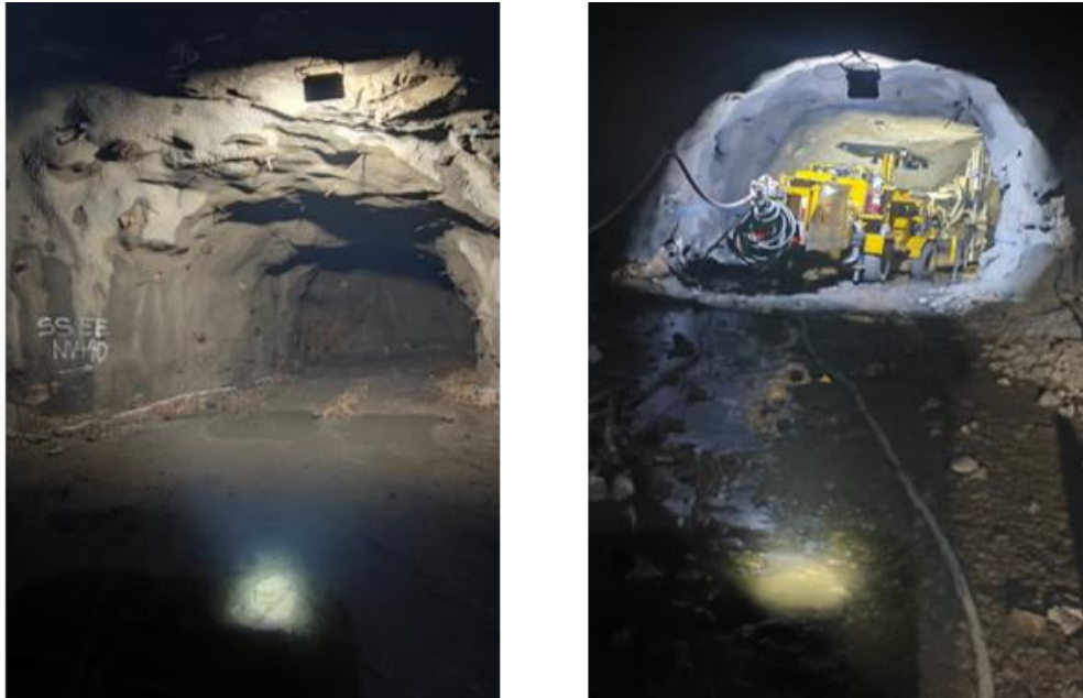
Figura 16. Shotcreteado de paredes y techo.
