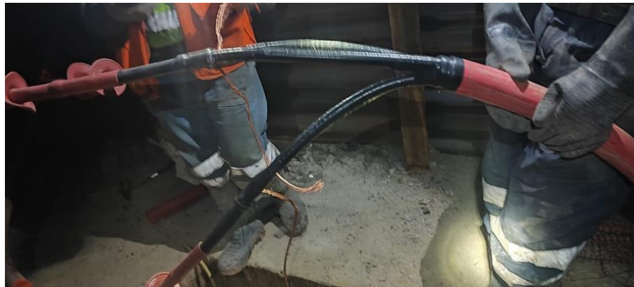
Figura 25. Terminaciones termocontraíbles y autocontraíbles.
