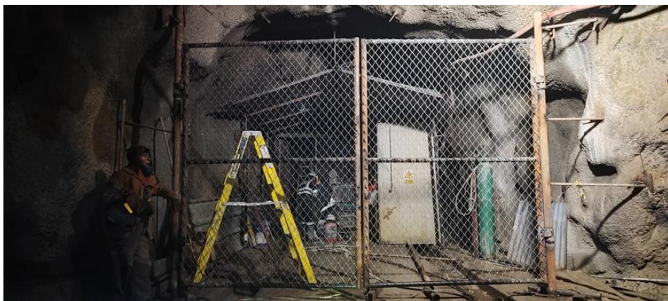
Figura 23. Construcción del portón principal de la subestación
