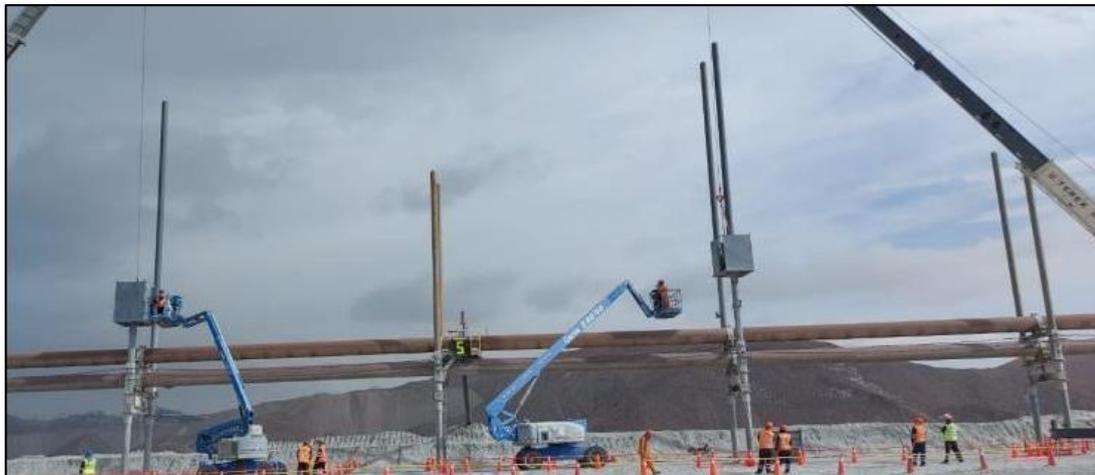
*Figura 2. Crecimiento vertical del Jacking Header, presa de relaves, fabricaciones de la empresa IMCO Servicios*
