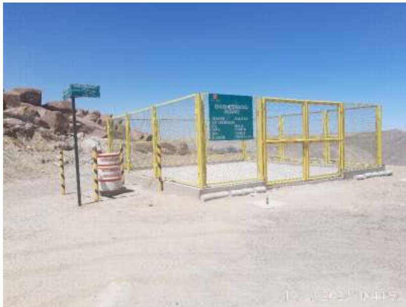
Figura 20. Cerco de enmallado metálico de EMA.
