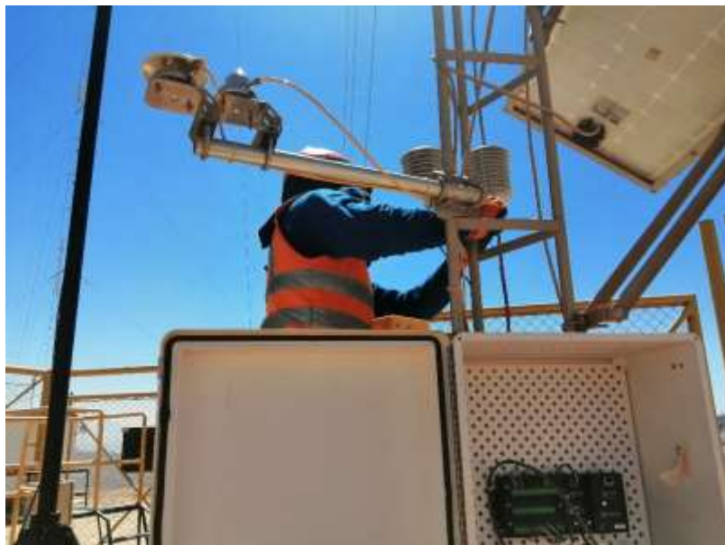
Figura 21. Instalación de estructura de soporte.
