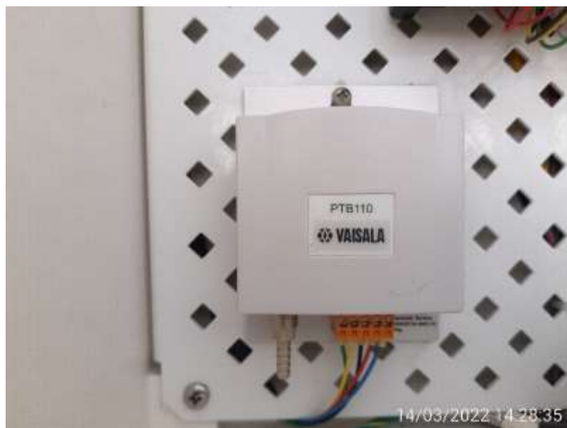
Figura 24. Instalación de sensor de Presión Atmosférica.
