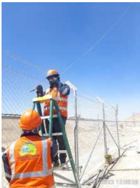
Figura 22. Instalación de Mástil meteorológico.
