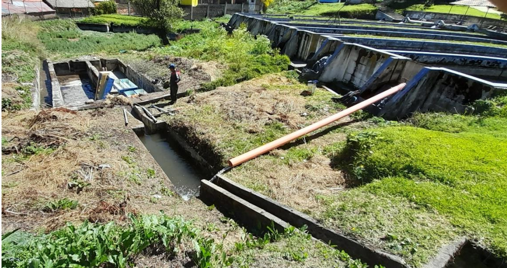
Figura 32. Limpieza y acondicionamiento de la poza de sedimentación
