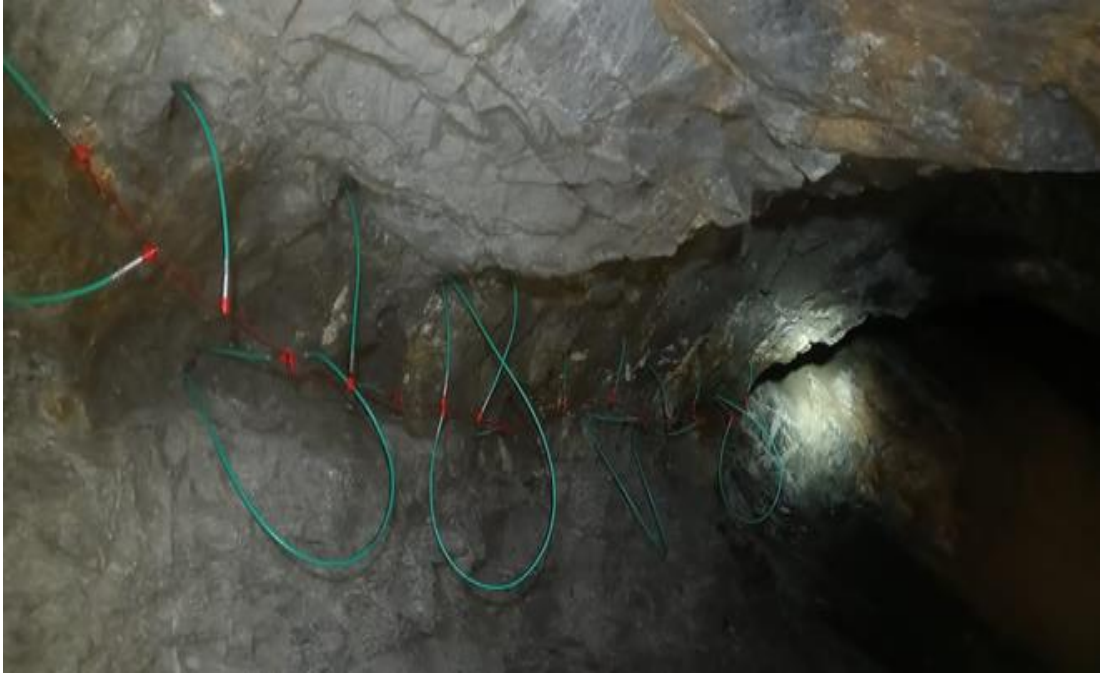
Figura 12. Método de minado corte y relleno ascendente con circado.
