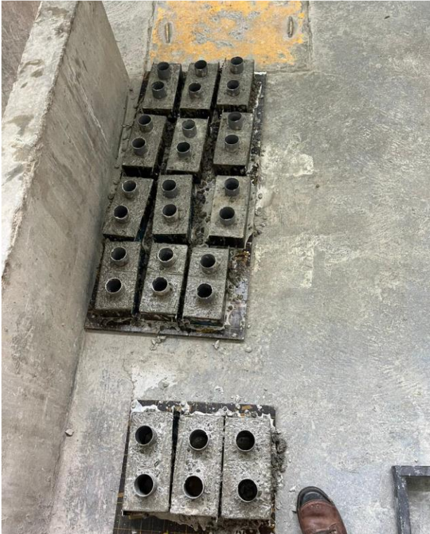
Proceso de fraguado de unidades de albañilería
