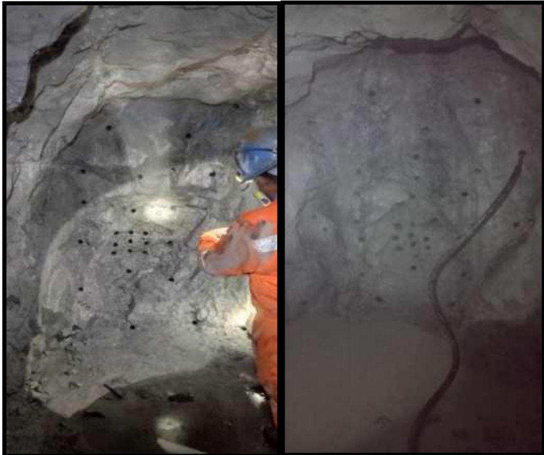
Figura 7. Comienzo de la toma de datos de la malla de perforación y voladura
