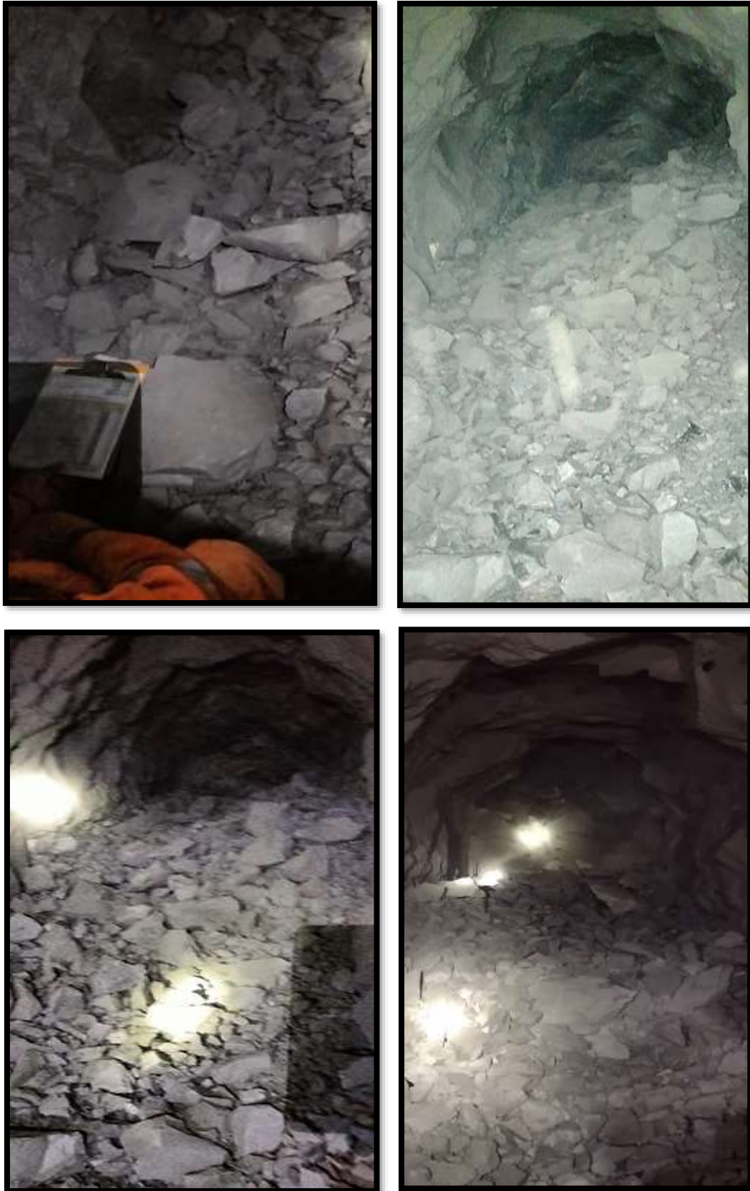
Figura 12. Se visualiza resultados de voladura y se detalla los trabajados en el anexo N°06, tabla N°27
