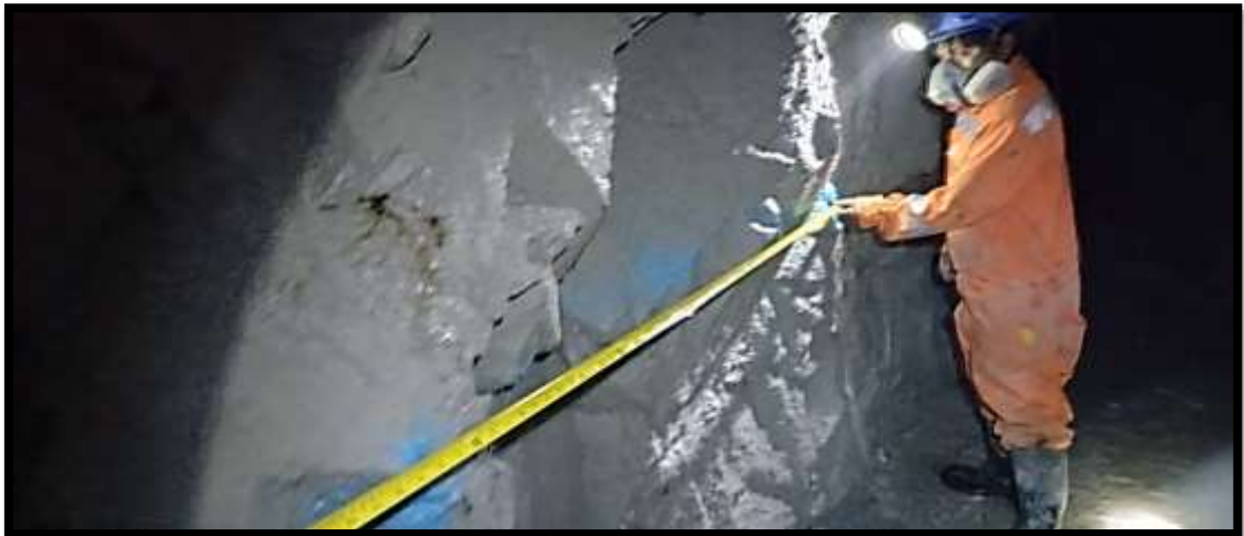
Figura 5. Logeo de metros de profundidad en los hastiales, índice de calidad de la roca (RQD), Galería Veta Soledad.
