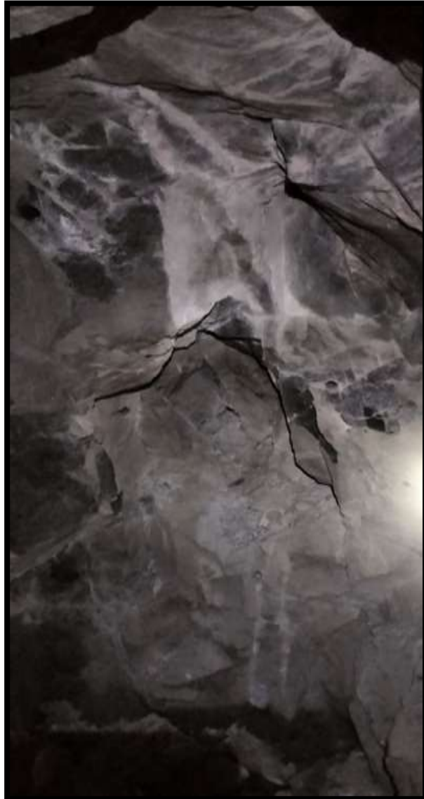
Figura 16. Disparo fallido dentro de la aplicación de la nueva malla de perforación
