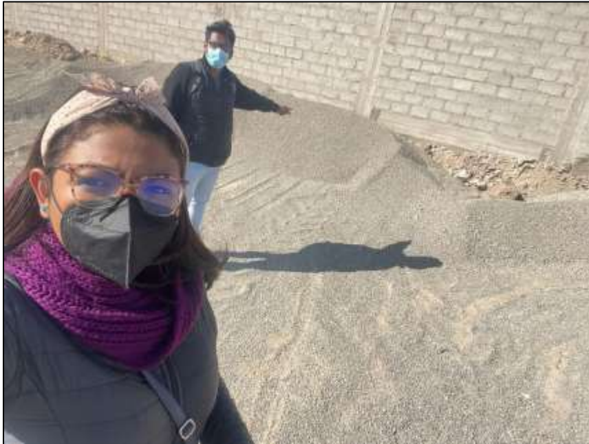
Fotografía 1. Acopio de agregado fino
