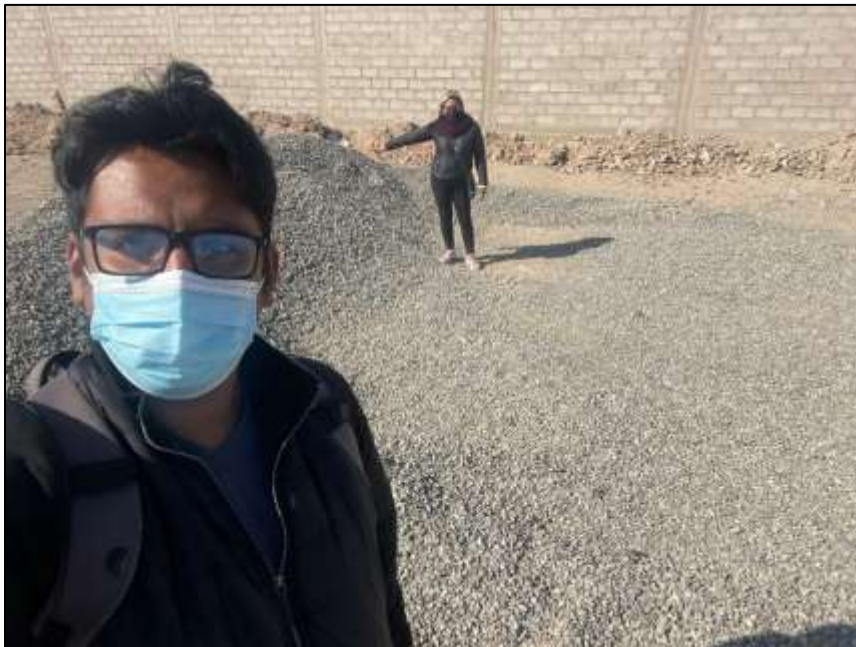
Fotografía 2: Acopio de agregado grueso
