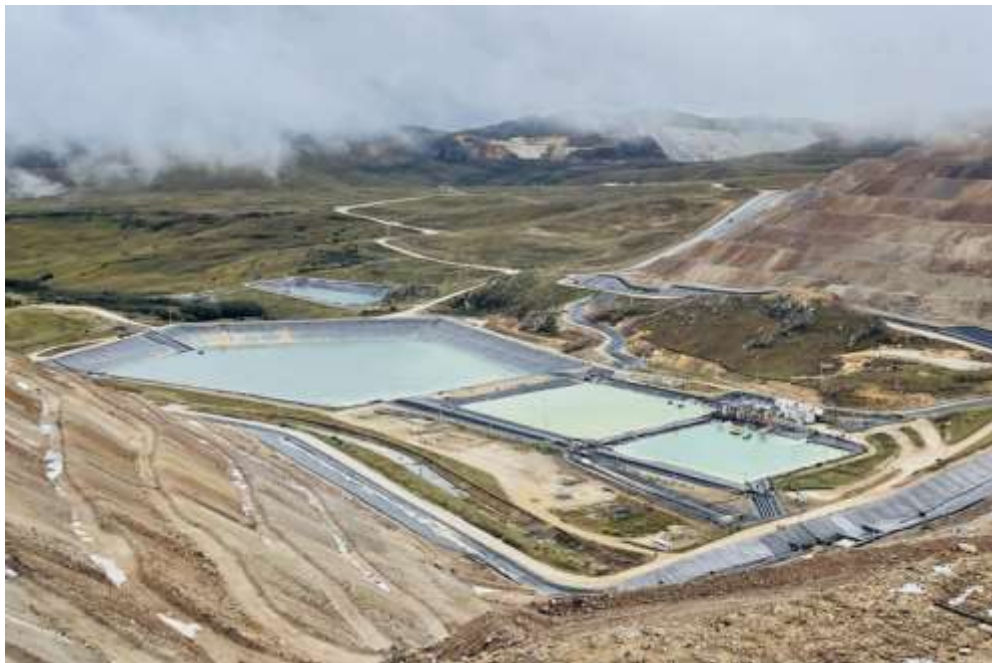
Figura 18. Pozas de captación y almacenamiento de solución rica lixiviada. (Newmont Yanacocha, 2023).
