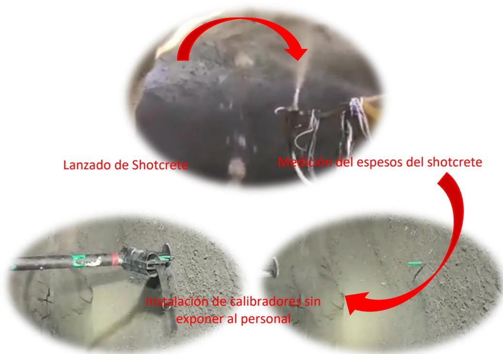
**Figura 32.** Proceso de calibración.
