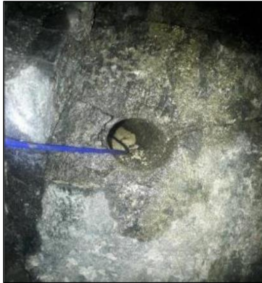
Figura 30. Control del uso de cordón detonante
