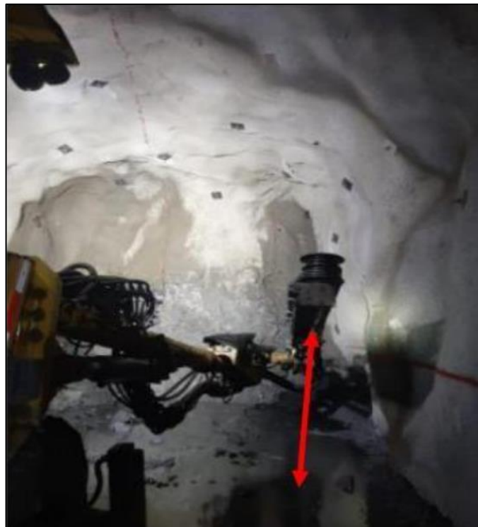
Figura 25. Perforación del frente de trabajo
