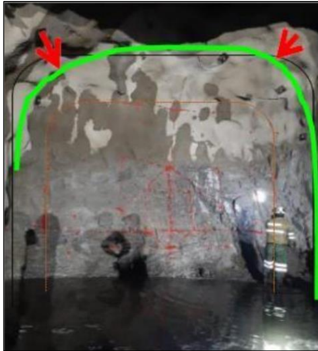
Figura 26. Control de sobre excavación
