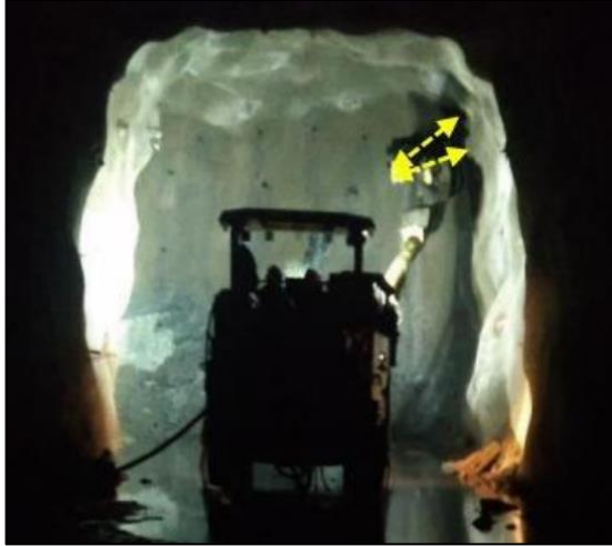
Figura 28. Control de ángulo de perforación
