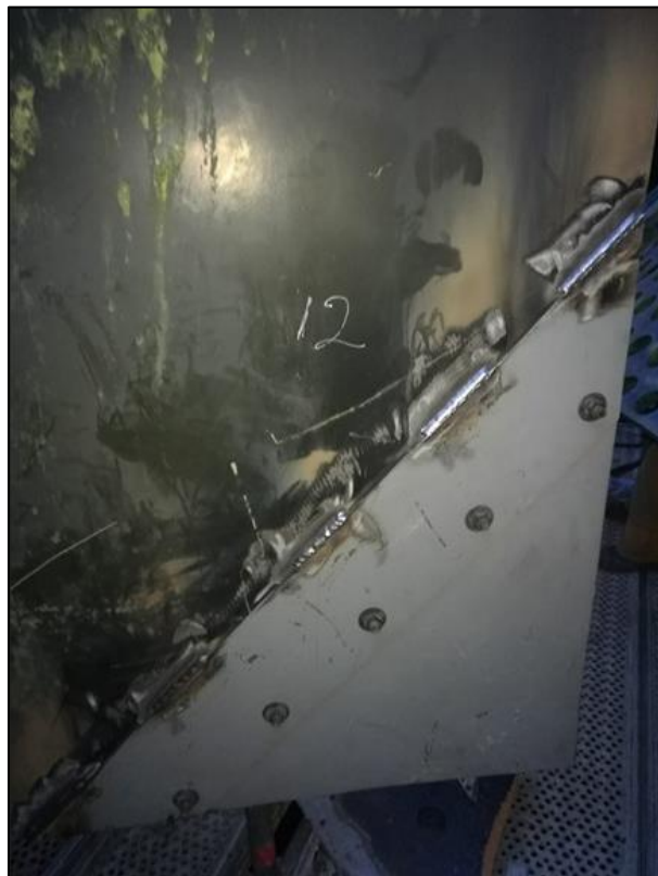
Figura 40. Soldadura de celda modificada
