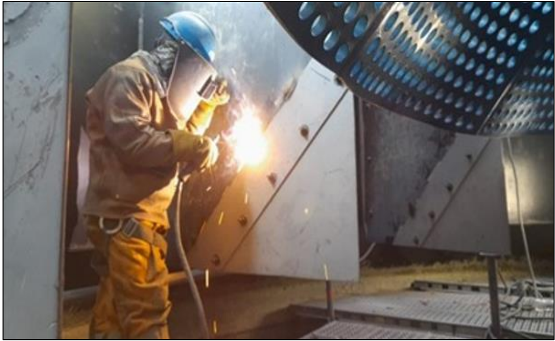
Figura 39. Instalación de celda modificada
