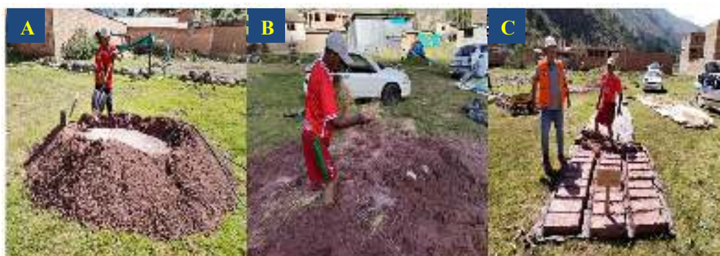
Figura 9. Elaboración de adobes. A) Preparación del barro; B) Proceso de mezclado del barro; C) Secado de las unidades de adobes a cielo abierto. Imágenes tomadas en la zona de estudio, Unuraqui, Calca, Cusco
