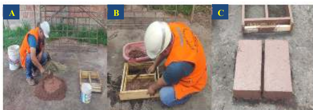
Figura 8. Cálculo de las cantidades de material. A) Mezcla del barro; B) Elaboración de adobe en molde de dos unidades; C) Secado de las unidades de adobe a cielo abierto. Imágenes tomadas en la zona de estudio, Unuraqui, Calca, Cusco
