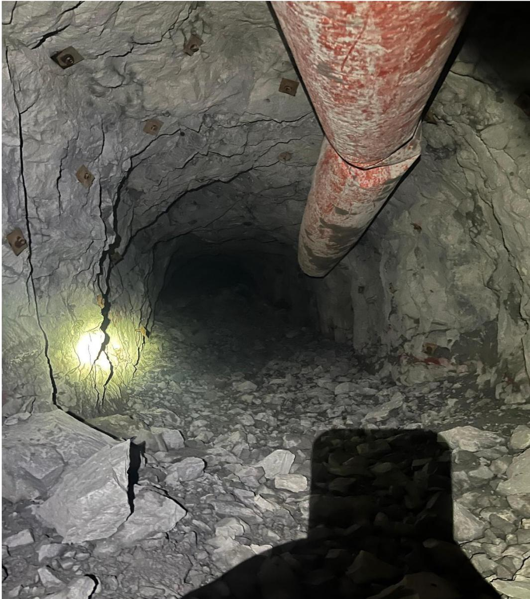
*Figura 10. Granulometría post voladura, Nv 4480*
