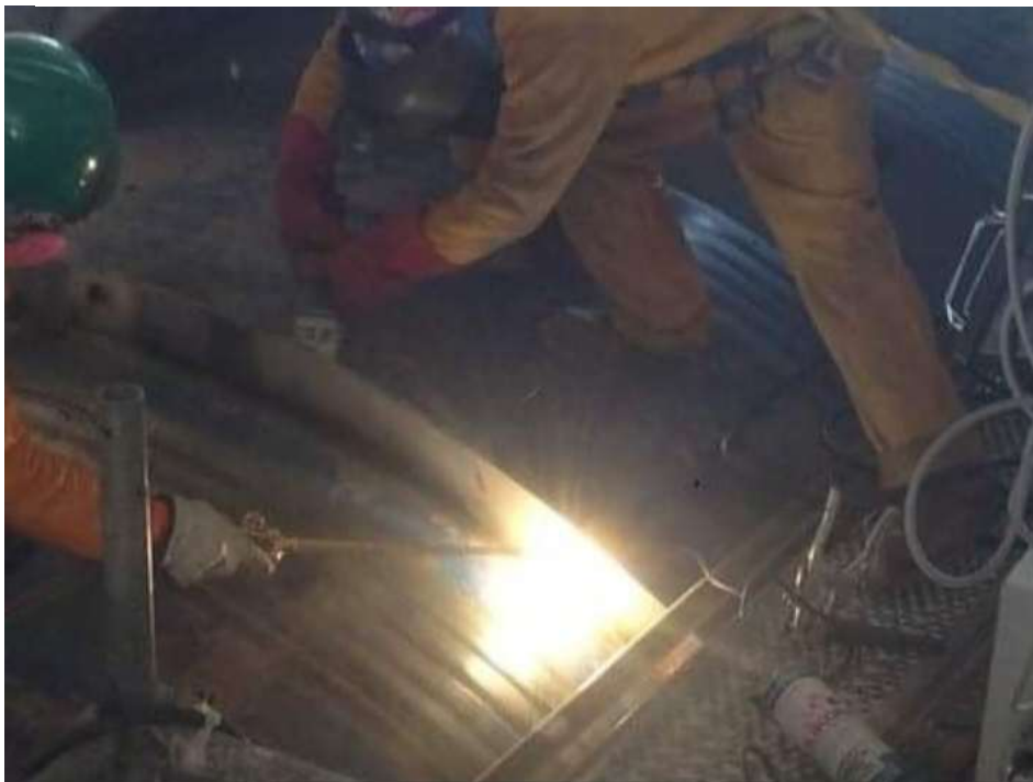
Figura 12 Reparación de fisuras del tambor lavador
