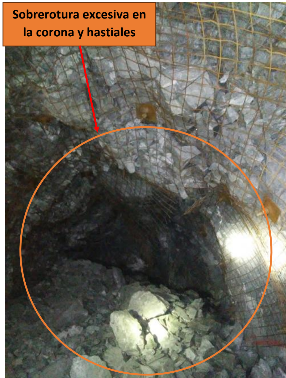
Figura 7. Análisis situacional del análisis de la sobrerotura del Bypass 9117 – NE
