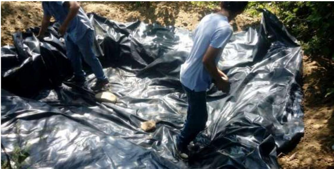
**Figura 7.** Medición del pozo piloto del sistema fitorremediador y proyección de la geomembrana. Elaboración propia.
