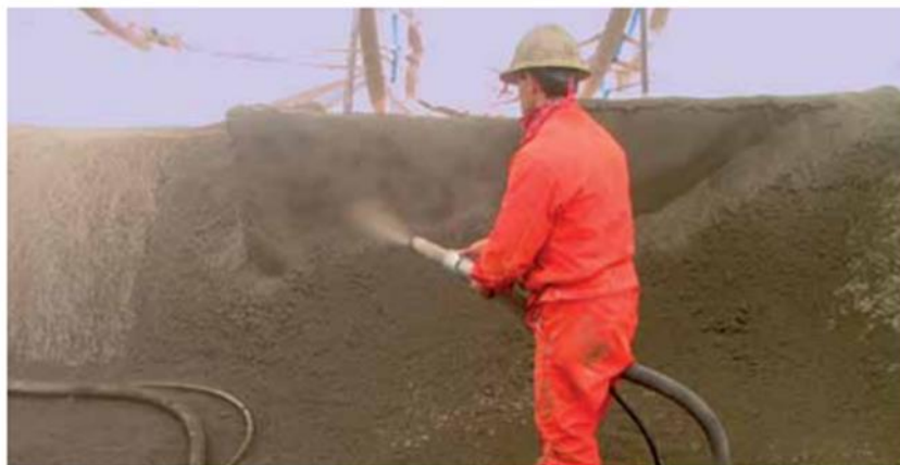
Figura 1. Shotcrete proyectado en seco Tomada del Manual hormigón proyectado.pdf
