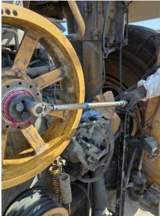
Reparación de mando ventilador
