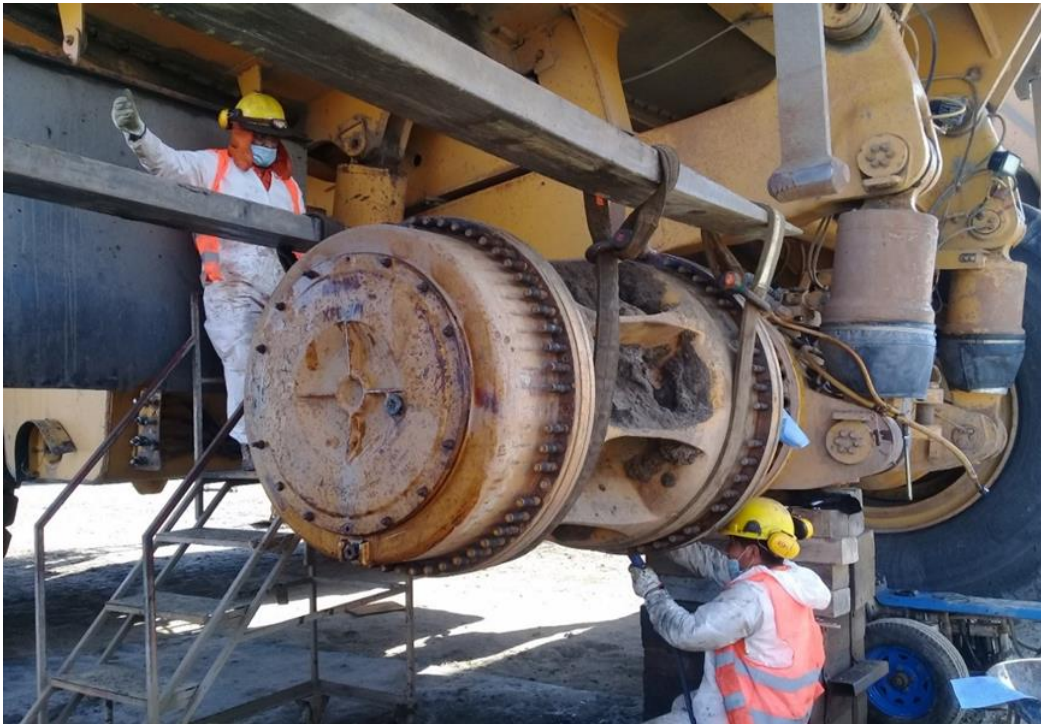
Desmontaje de mando final
