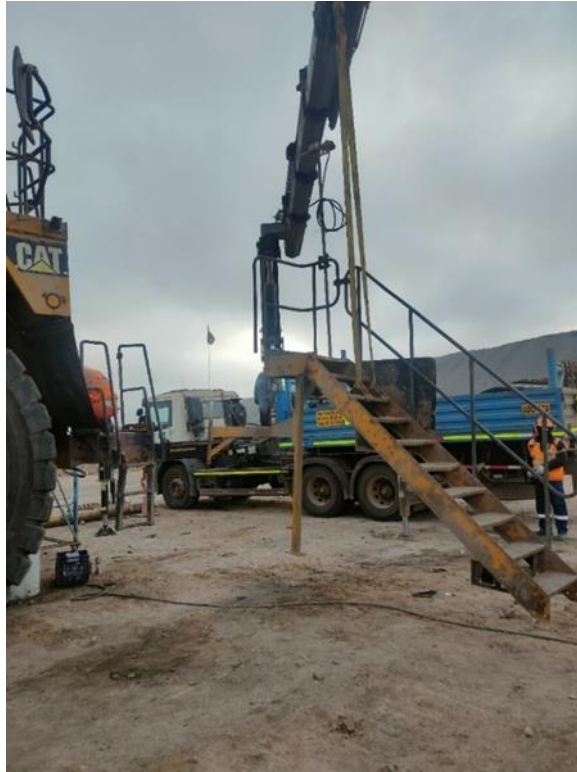
Desmontaje de componentes de camion 785D
