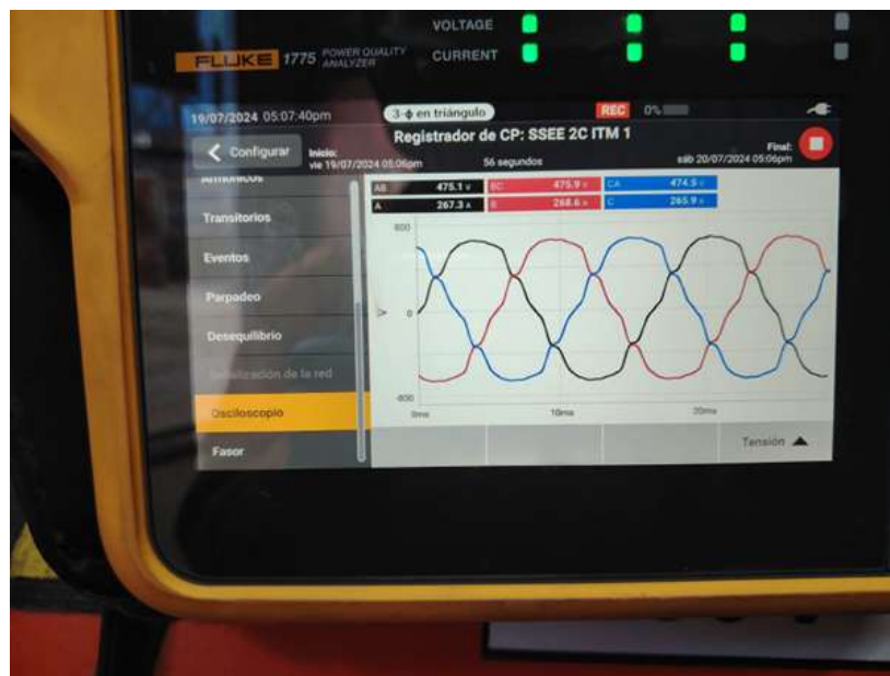
Figura 25. Periodo de medición de voltaje 460 V Fuente: Analizador Fluke 1775
