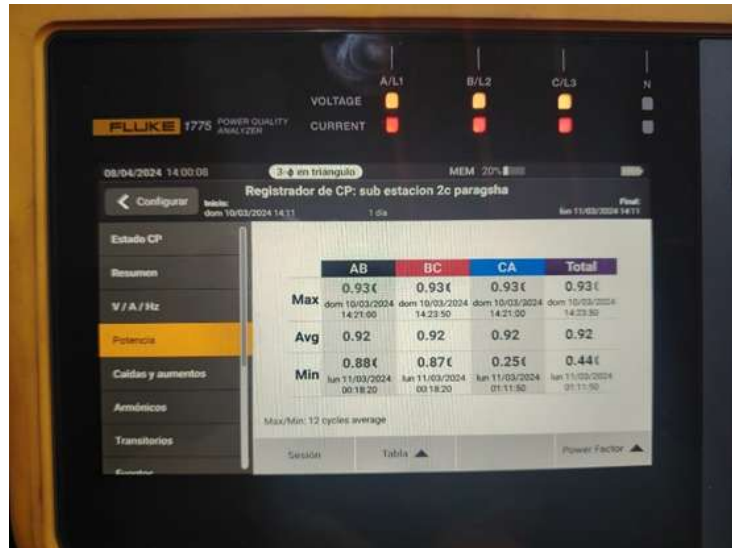
Figura 23. Periodo de medición de factor de potencia Fuente: Analizador Fluke 1775
