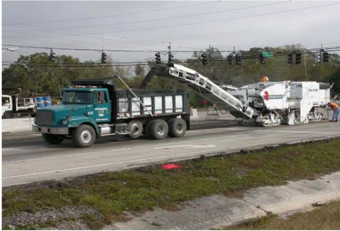
Figura 5. Máquina fresadora de asfalto y remolque volquete
