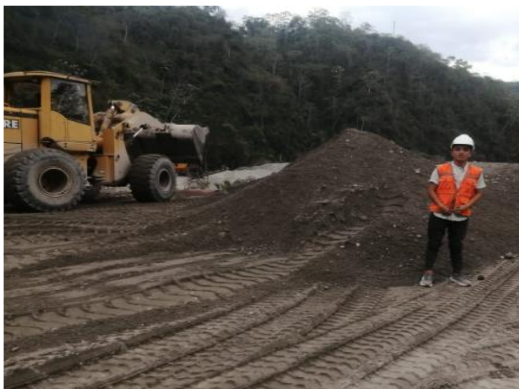
2. Extracción de agregados de la cantera de Chanchamayo
