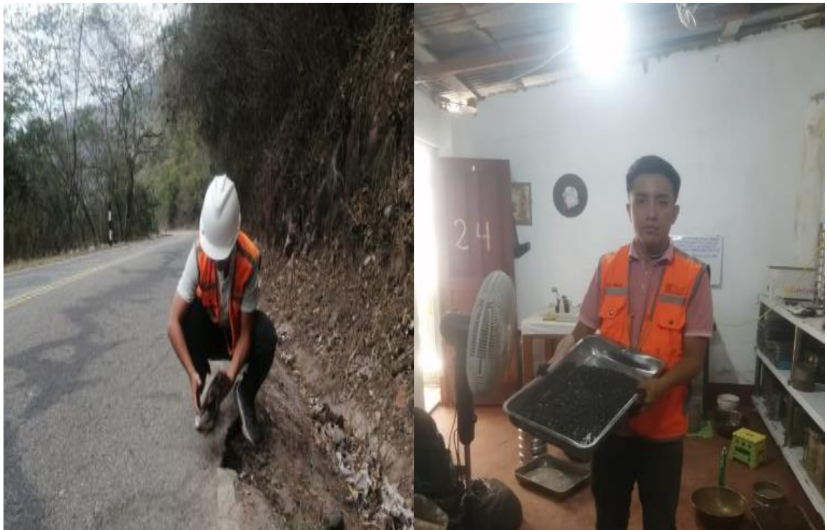
16. Material reciclado obtenido del subtramo 4 del tramo Perené – Pichanaqui, según la norma MTC E 502
