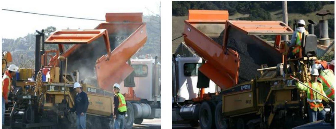
Figura 2. (a) Colocación de mezclas asfálticas calientes (b) Colocación de mezclas asfálticas semicalientes
