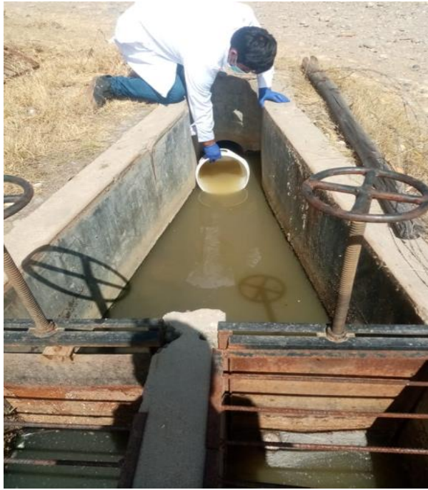
Fotografía que muestra la colección de muestra del afluente a la planta de tratamiento de agua
