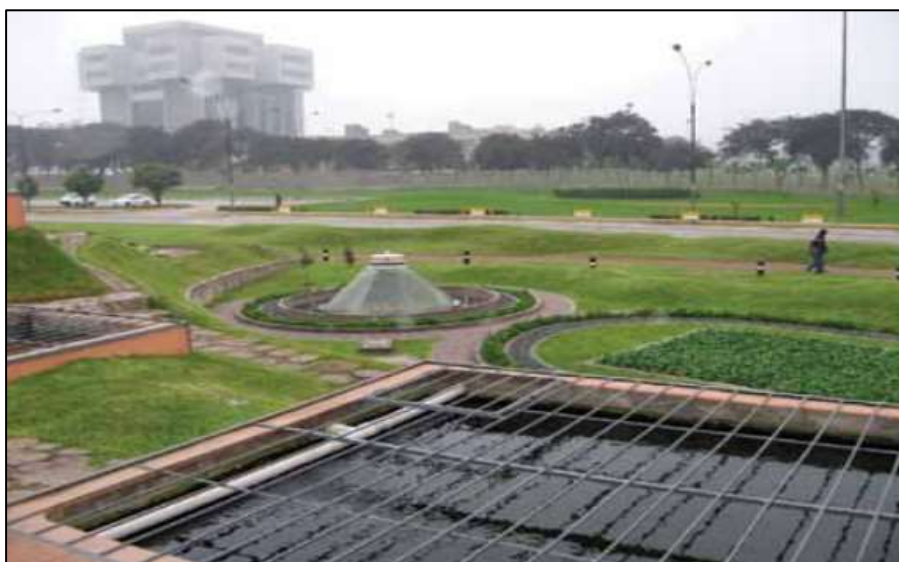
Figura 10. Biofiltro aerobio cubierto con paneles transparentes.
