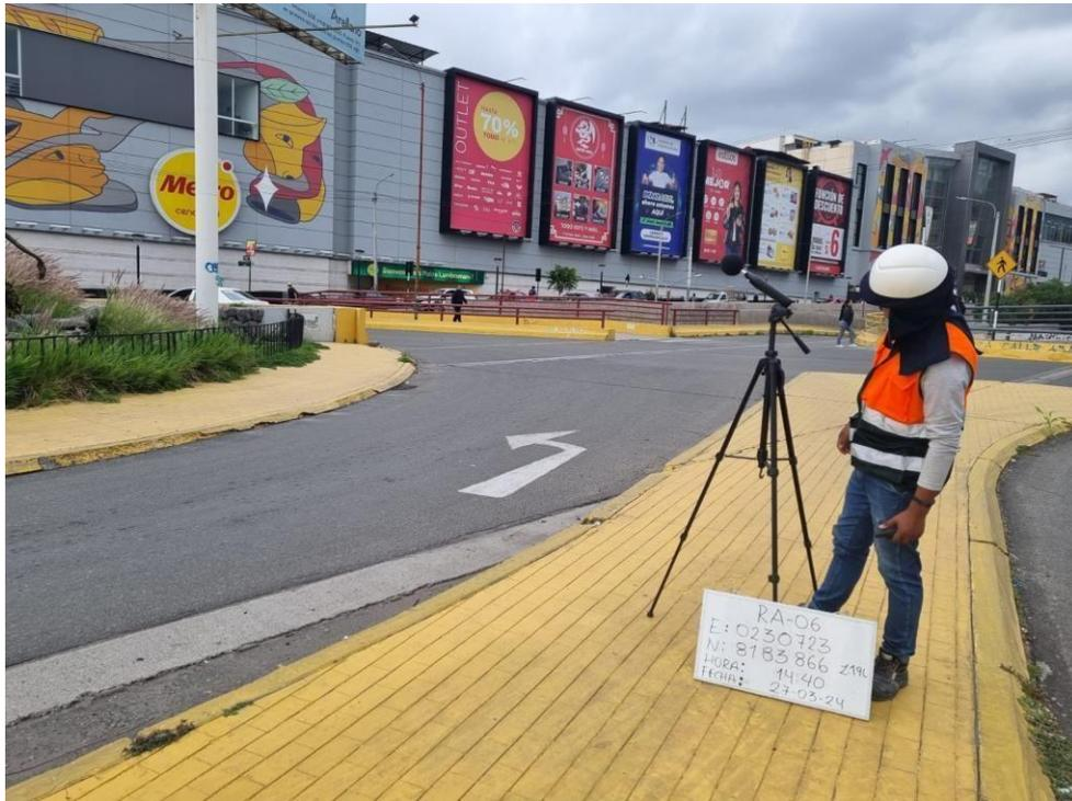
**Fotografía N°2:** *Instalación del punto RA-05 en el ovalo de la Av. Dolores y la Av. los incas*
