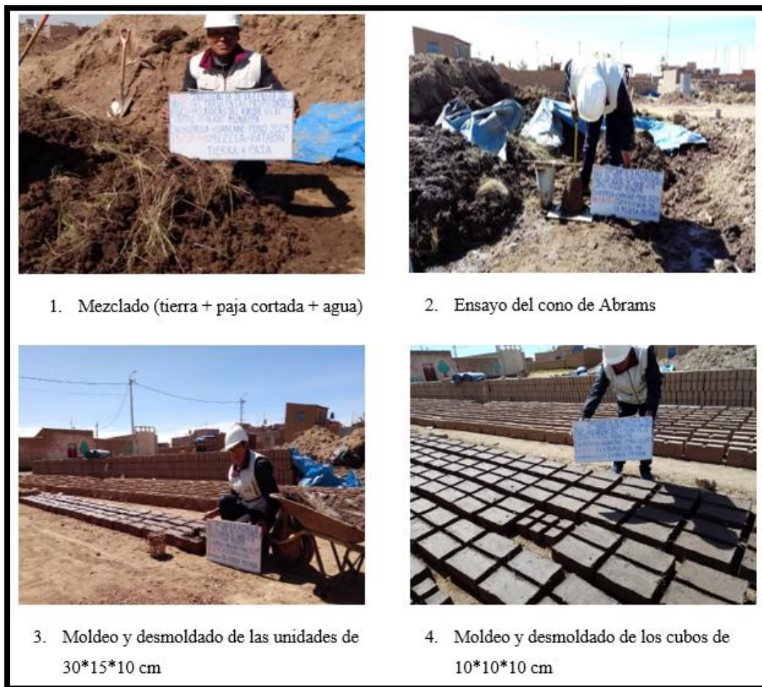
Figura 25 Proceso de Elaboración de las Unidades y Cubos Patrón
