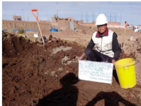
1. Mezclado (tierra + paja cortada + 3.25 % CTT + agua)
