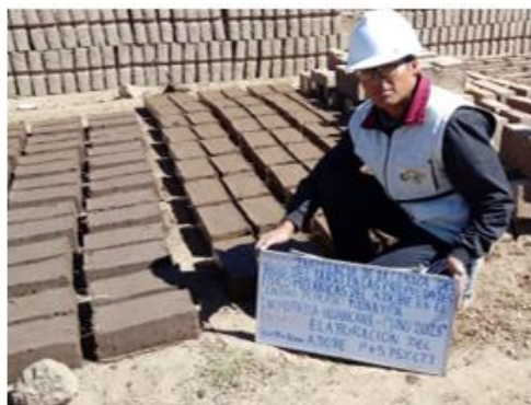
3. Moldeo y desmoldado de las unidades de 30*15*10 cm
