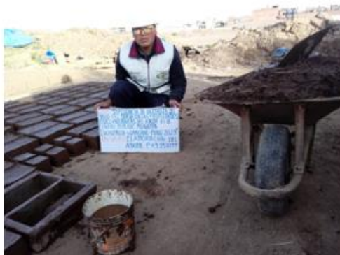
3. Moldeo y desmoldado de las unidades de 30*15*10 cm
