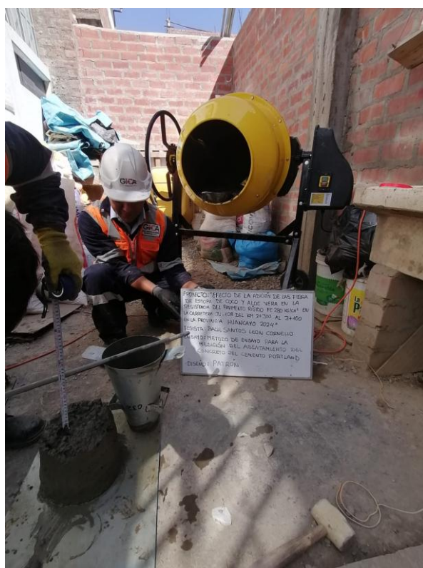
Figura 62. Panel Fotográfico- Preparación de mezcla y ensayo de Slump
