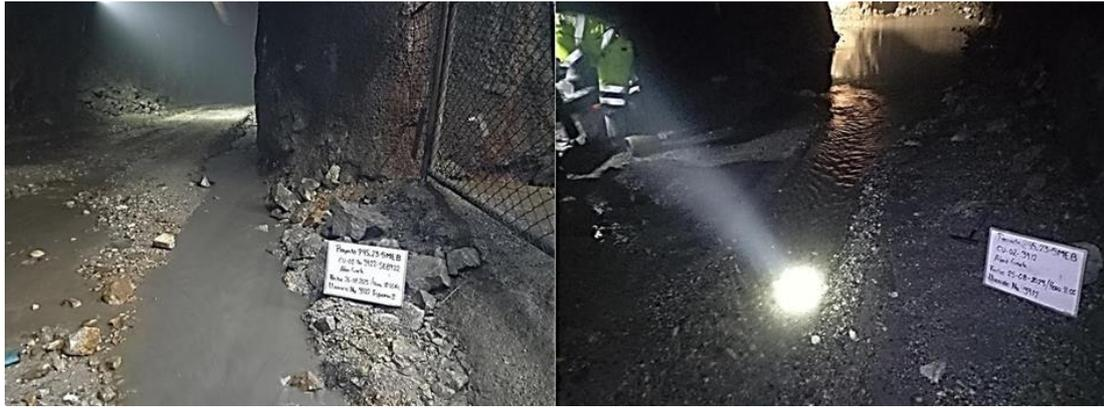
**Figura 14.** Izquierda: aforo en rampa Esperanza que reúne filtraciones del nivel 3922. Derecha: filtraciones del nivel 3912
