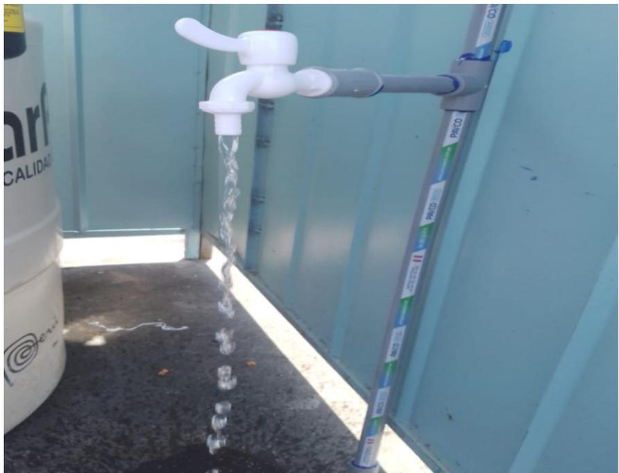
Figura 17. Disposición del grifo de agua, a base de PVC.
