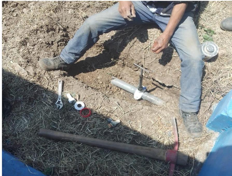
Figura 13. Instalación de tubería de ingreso de agua, con la abrazadera.
