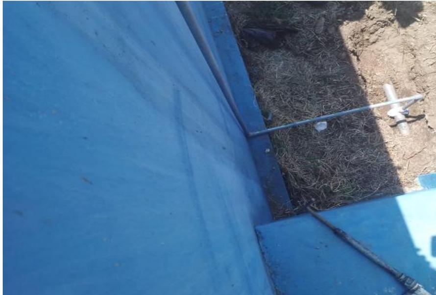
*Figura 14.* Instalación terminada para el ingreso del agua al sistema.
