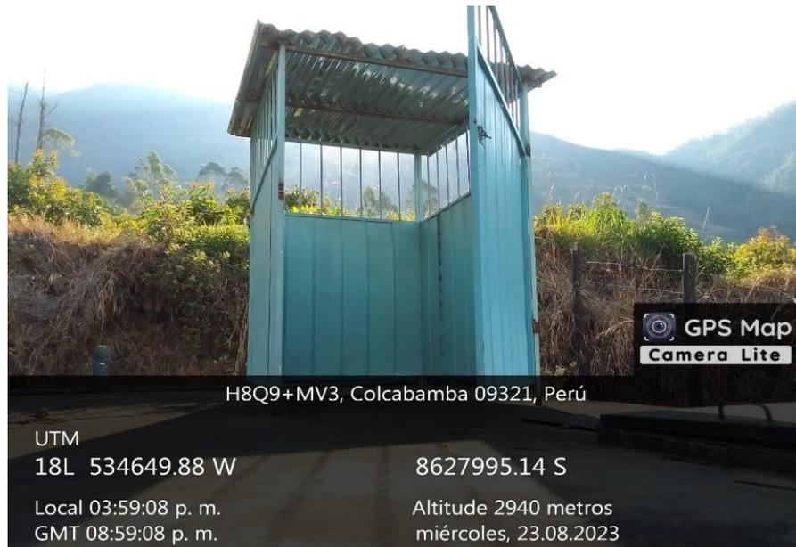
Figura 12. Caseta de cloración del sistema de agua potable.
