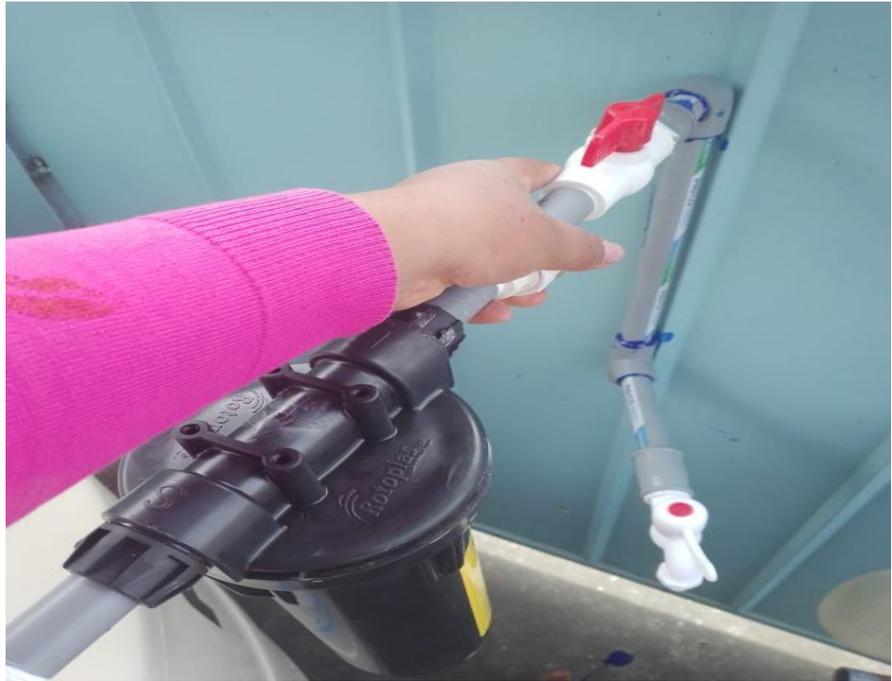
Figura 16. Instalación del filtro de anillo, unión universal, codo, tubo y adaptadores.
