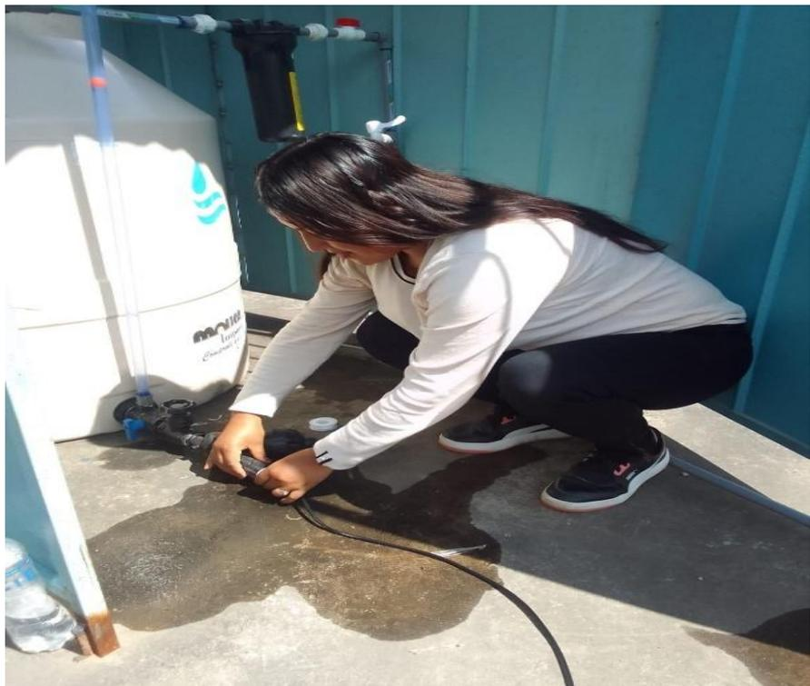
*Figura 19.* Unión del multiconector con el bushing hexagonal, incluido el gotero autocompensante.
