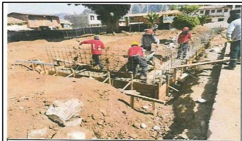
*Figura 20. Vaciado de la cimentación de sardineles*
