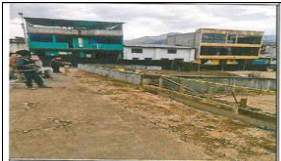
*Figura 23.* Encofrado de bancas, rampas y veredas
