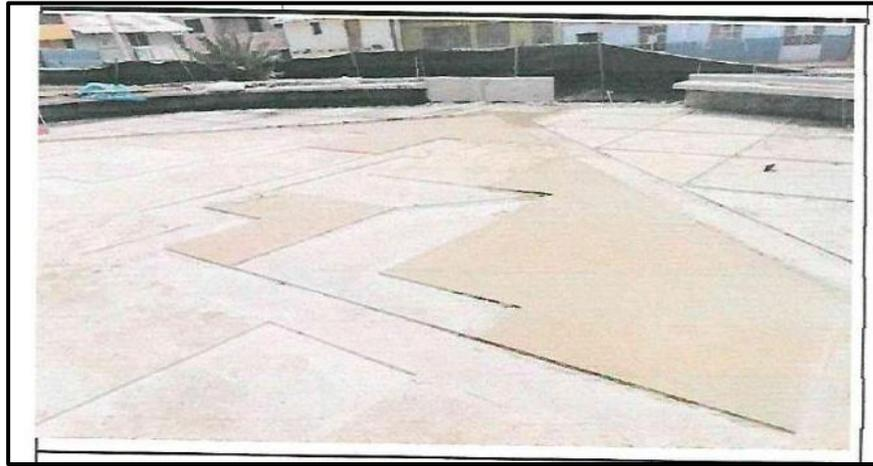
*Figura 26. Colocación de terrazo pulido en pisos y bancas*
