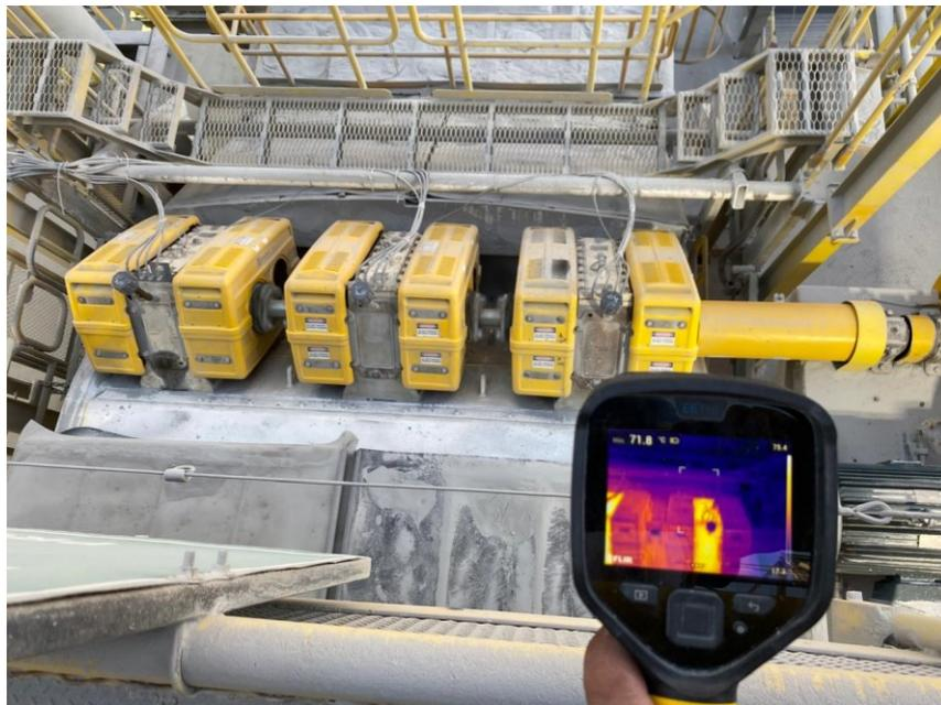
Figura 23. Toma de temperatura de excitadores de zarandas secas. Imagen tomada en planta concentradora C2.
