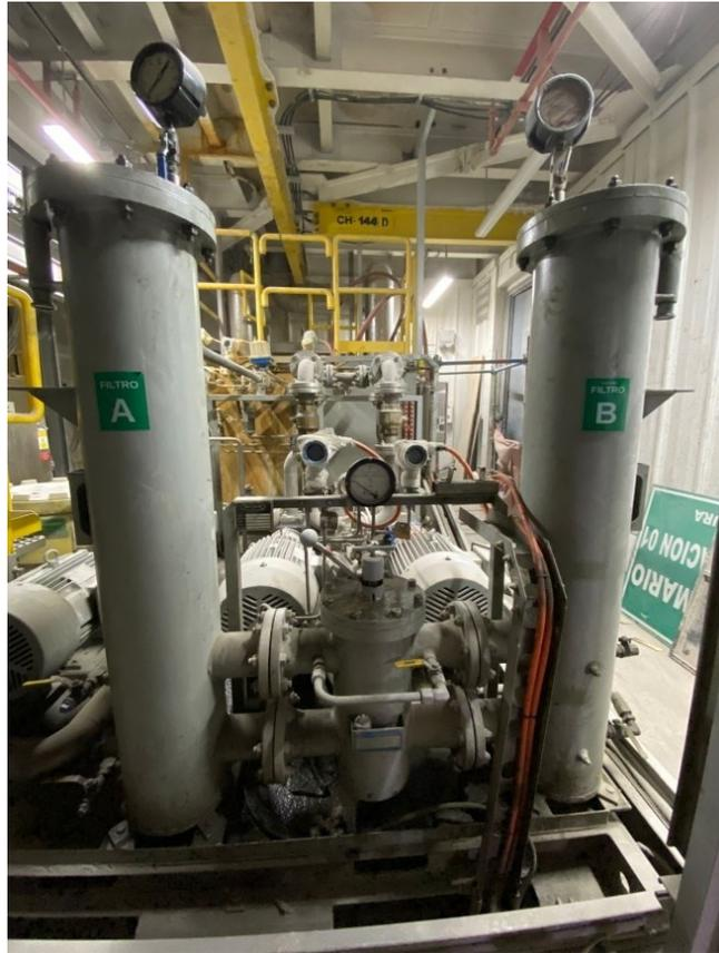
Figura 20. Banco de filtros del sistema de lubricación CH primario. Imagen tomada en planta concentradora C2.
