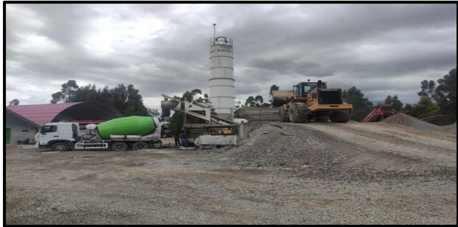
Figura 9. Descarga del concreto de dosificadora al mixer
