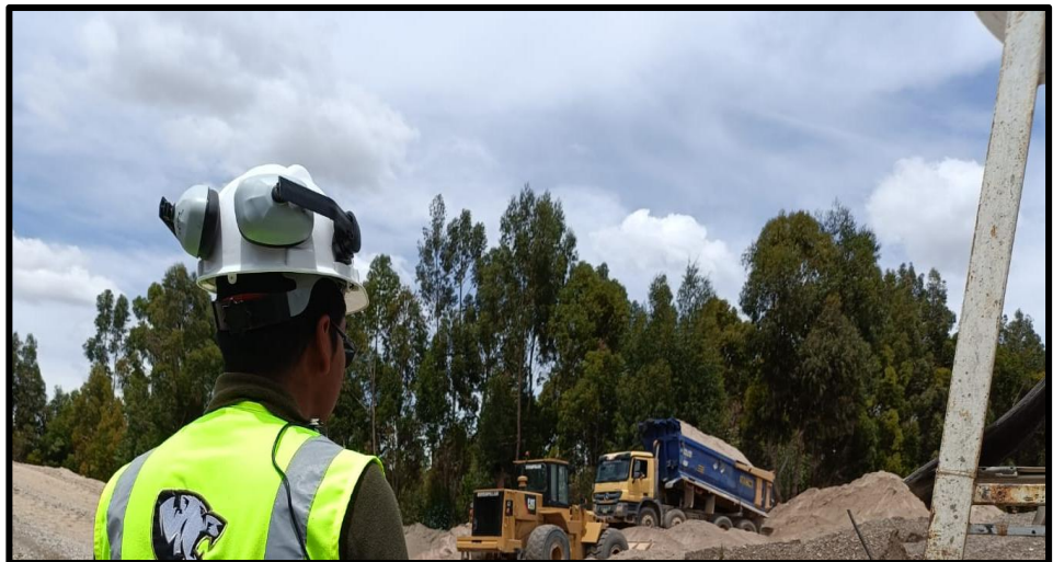
Figura 8. Desmonte de agregados- vaciando agregado el volquete.
