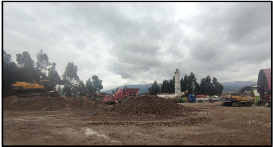
Figura 7. La cargadora frontal llenando agregado a la chancadora.
