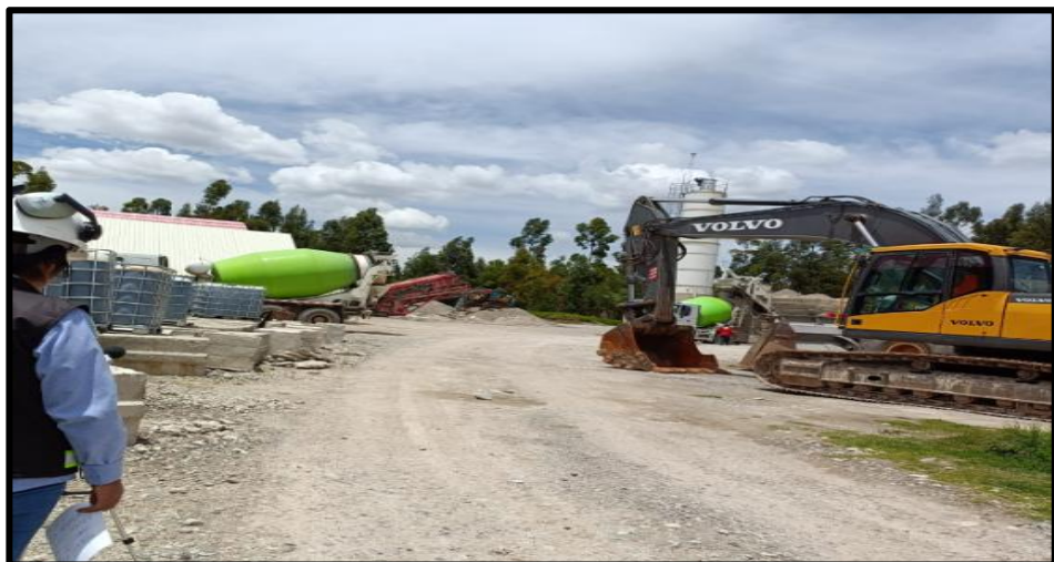
Figura 10. Descanso de las maquinarias para la hora de receso.
