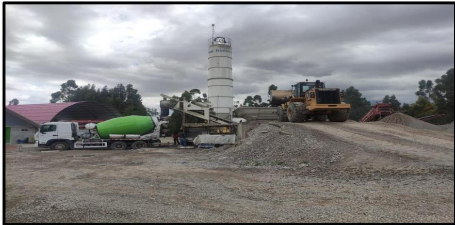
**Figura 9.** Descarga del concreto de dosificadora al mixer
