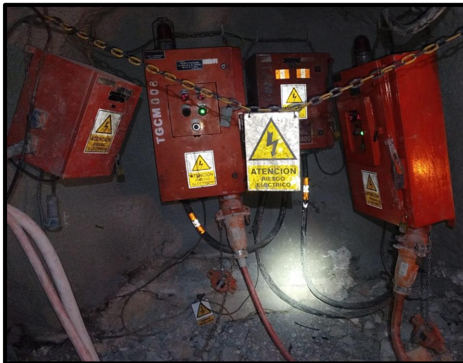
Figura 9. Conectores Pentapolares.
