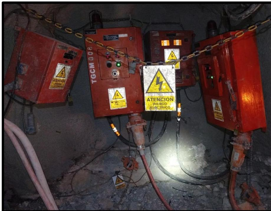
Figura 9. *Conectores Pentapolares.*
